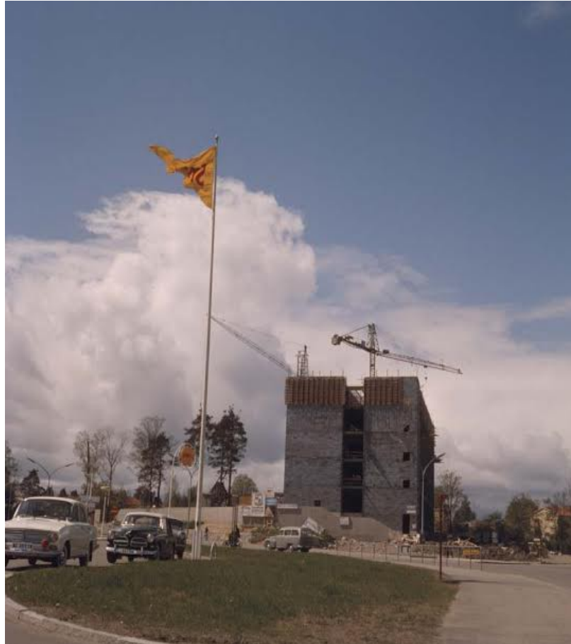
Bild 8: Byggnadsarbete hus A 1962
