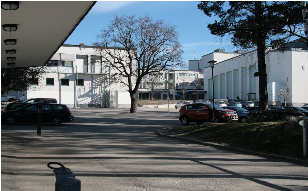
Bild 2: Vy från skolmatsalen mot skolgård, konserthallen, hus B och C
