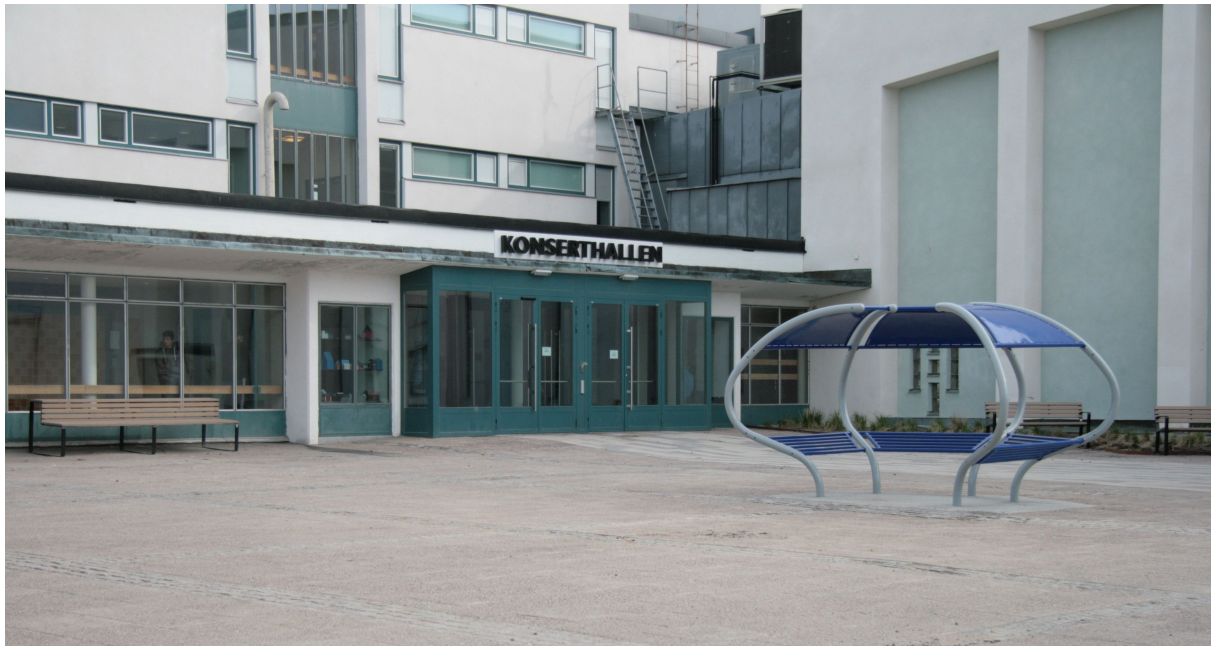
Bild 16: Konserthallens entré från skolgården
