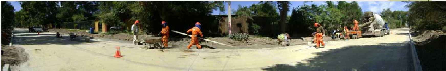
TRABAJADORES EN CALLE PAICAVI VILLA MAPUHUE
