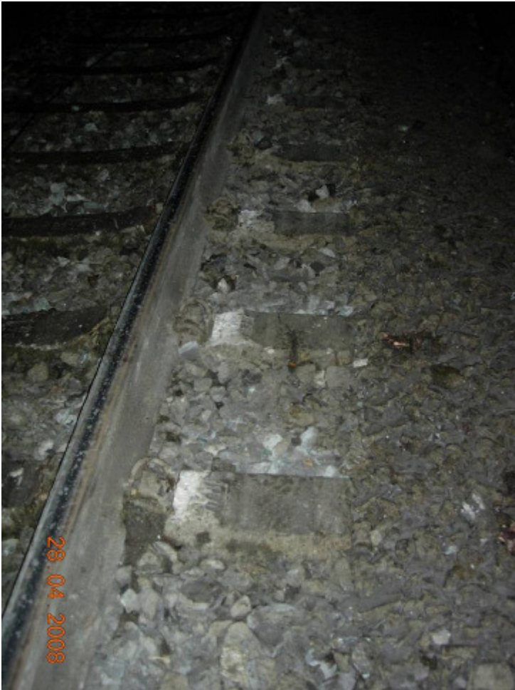
Abbildung 9: Entgleisungsspuren in Fahrtrichtung rechts
