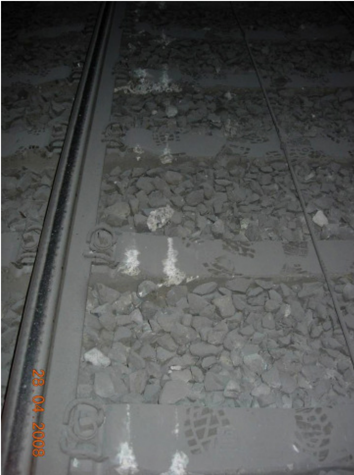
Abbildung 10: Entgleisungsspuren in Fahrrichtung links
