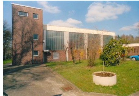
Das Wasserwerk Hornheide-Haskenau wurde 1938 aufgrund des gestiegenen Wasserbedarfs in Münster gebaut.
