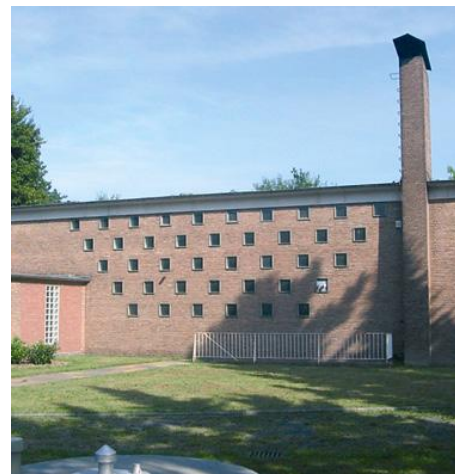
Das kleinste Wasserwerk in Münster steht in Kinderhaus und bereitet 130 m 3 Grundwasser pro Stunde auf.
