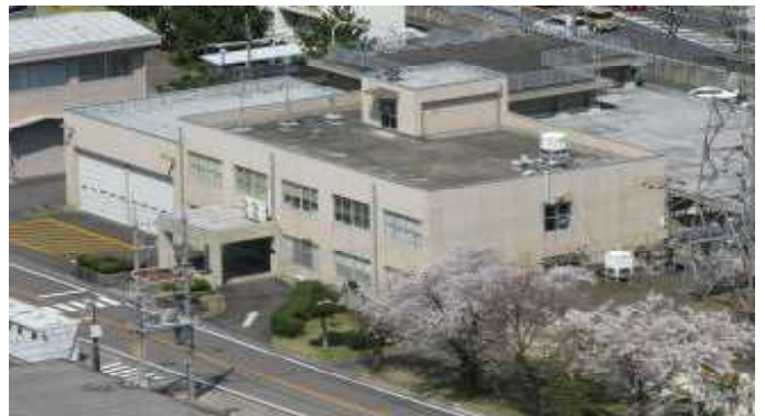
試験場庁舎（昭和55年度完成）
