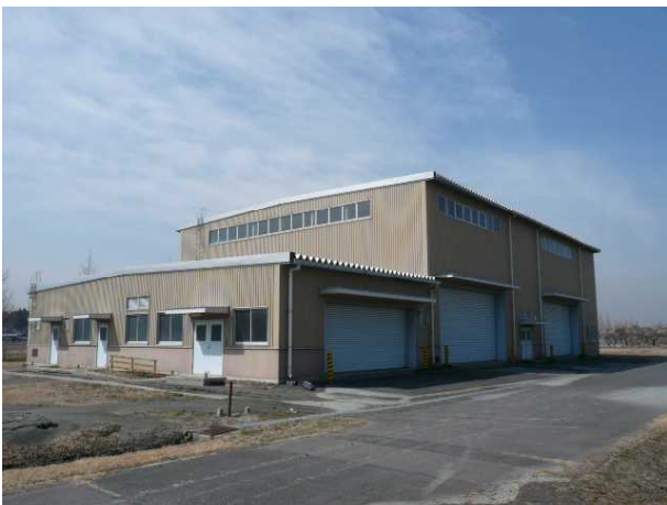
総合整備室（平成14年度竣工）
