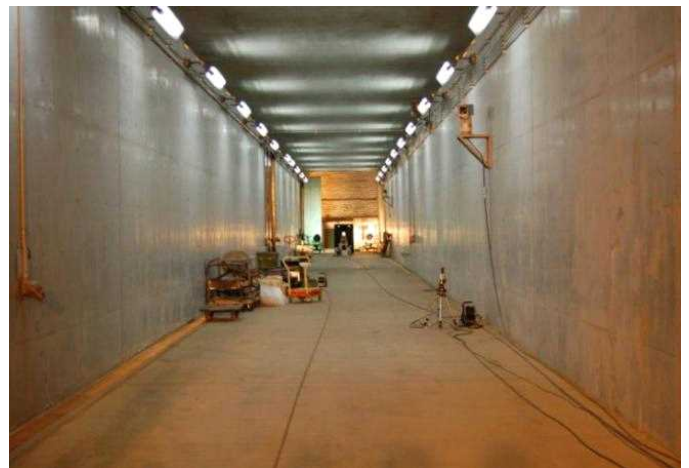
高速現象実験棟の実験室内部
