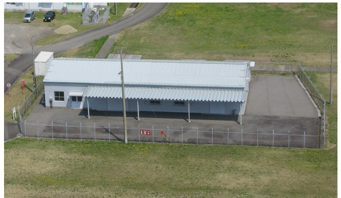
火工品組立作業場（平成21年度改修）
