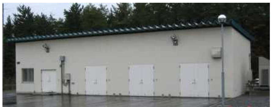
恒温室（弾薬恒温槽 3台）
