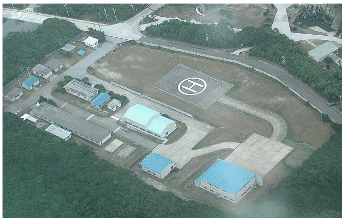
新島試験場管理地区全景
