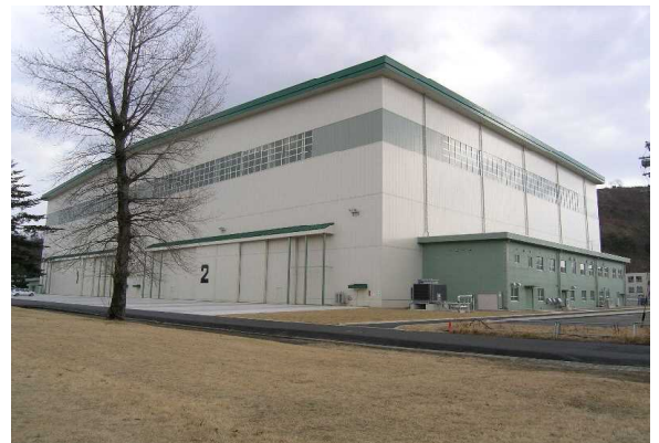
次期輸送機強度試験場
