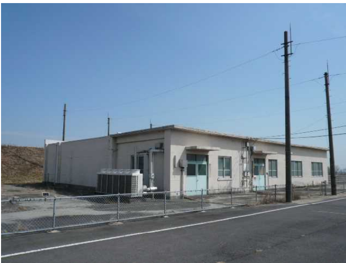
建替となった温度環境・老化試験室
