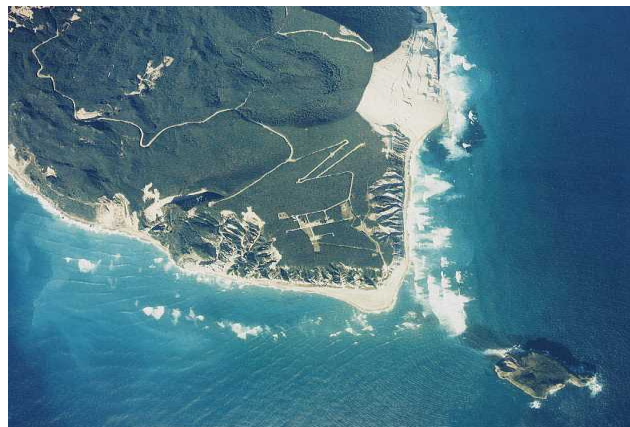
新島試験場射場地区全景
