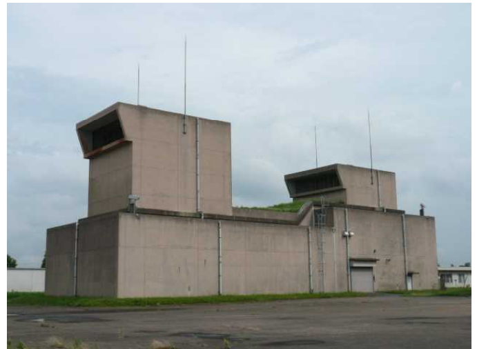
防爆型ロケット燃焼試験室（平成21年度改修）
