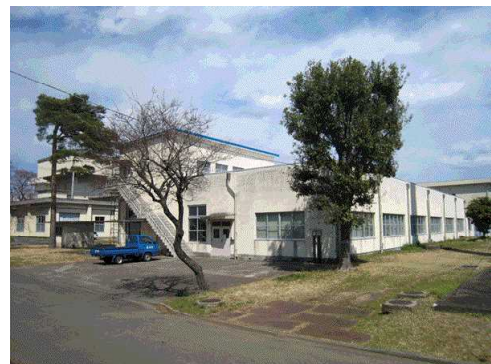
原動機整備工場
