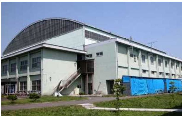
第 2 機体強度試験場
