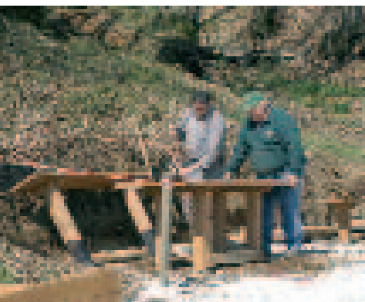
L'allestimento dell'area sosta
