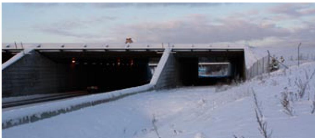
Figur 30 Vägporten under taxibana U används inte för nuvarande och kan med viss ombyggnad användas av Roslagsbanan.
