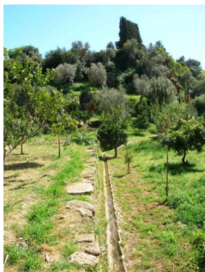
Saja - condotta idrica in canali di terra cotta e scavata nella roccia a cielo aperto
