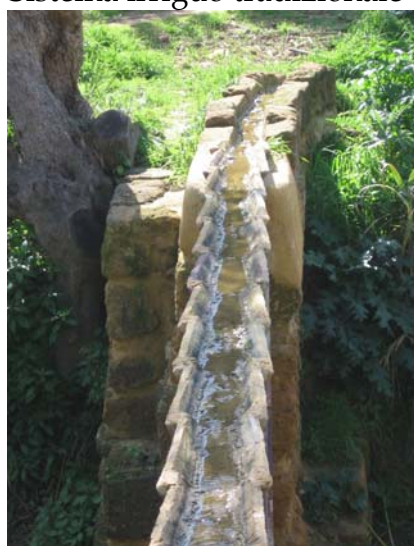
Saja - condotta idrica in canali di terra cotta e scavata nella roccia a cielo aperto
