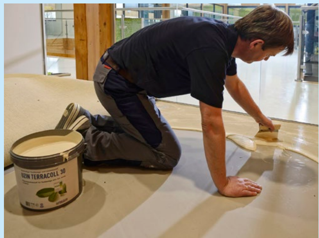
Typische Anwendung - Aufbringen eines lösemittelfreien Textilbelagsklebstoffs
