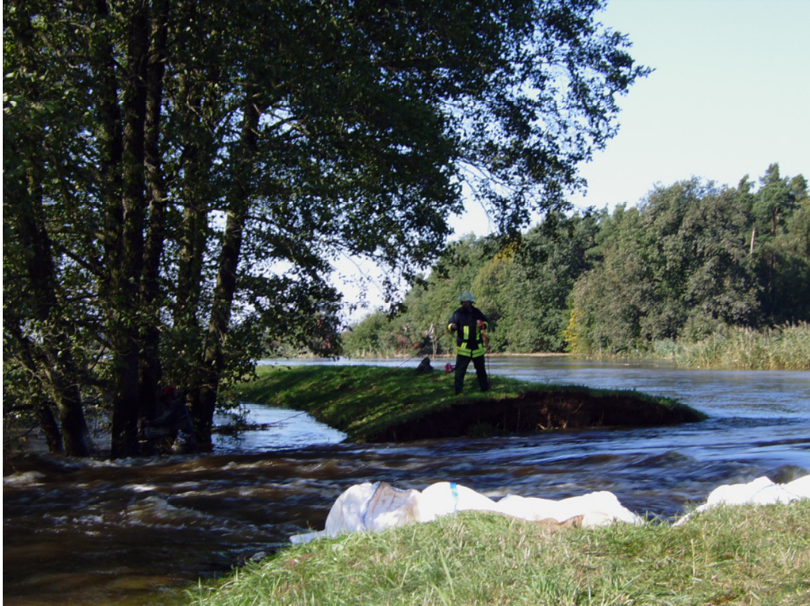
Deichbruch bei Meuselko
