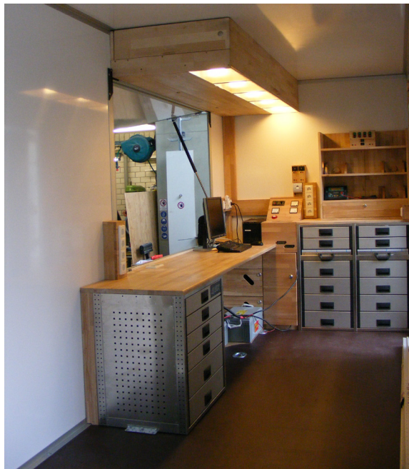
Abb. 5 Innenausrüstung der Bodenstation
