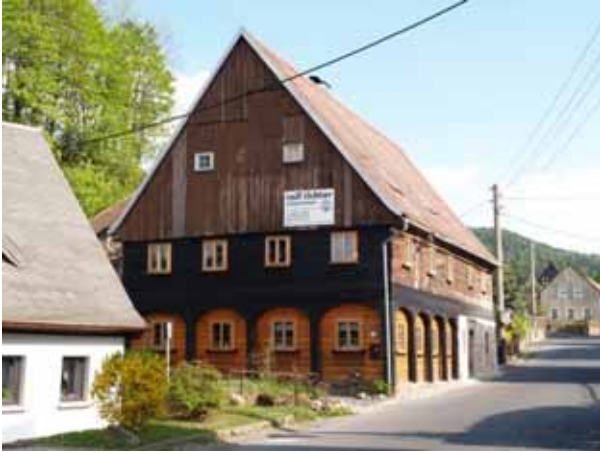
Foto 13. Waltersdorf, Beispiel eines Hauses mit Blockstube im Obergeschoss
