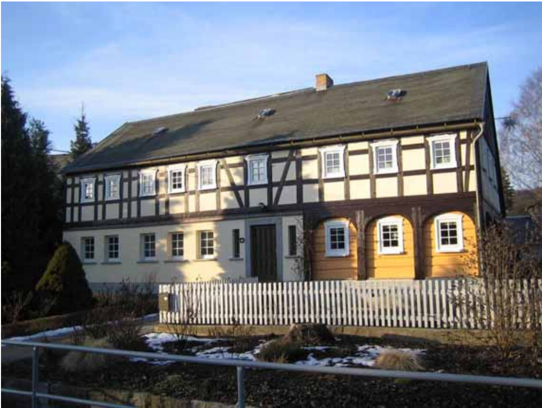
Wehrsdorf, Umgebinde, vor fünf Jahren mit Wetterschutzfarbe auf Naturölbasis behandelt.
