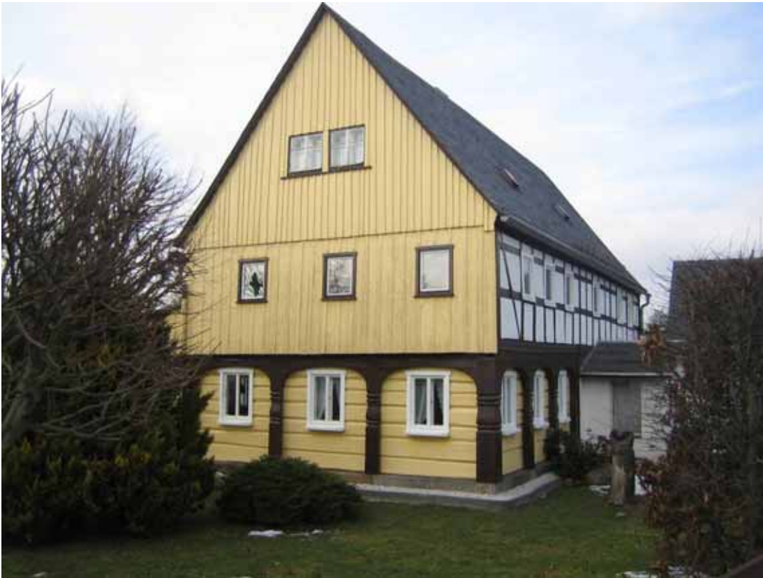
Steinigwolmsdorf, schichtbildende Wetterschutzfarbe, muss immer beobachtet werden.
