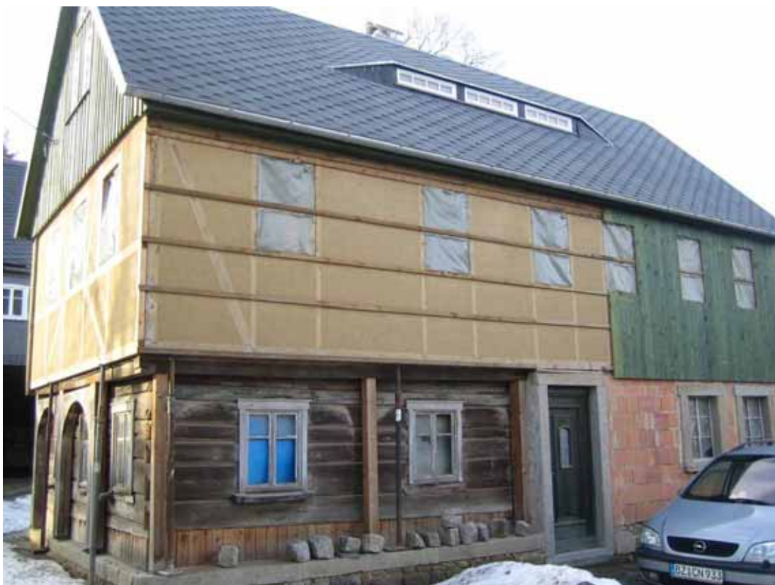
Steinigwolmsdorf, altes Umgebäude, noch in der Sanierung, wird im Obergeschoss mit Lehmwänden gedämmt.
