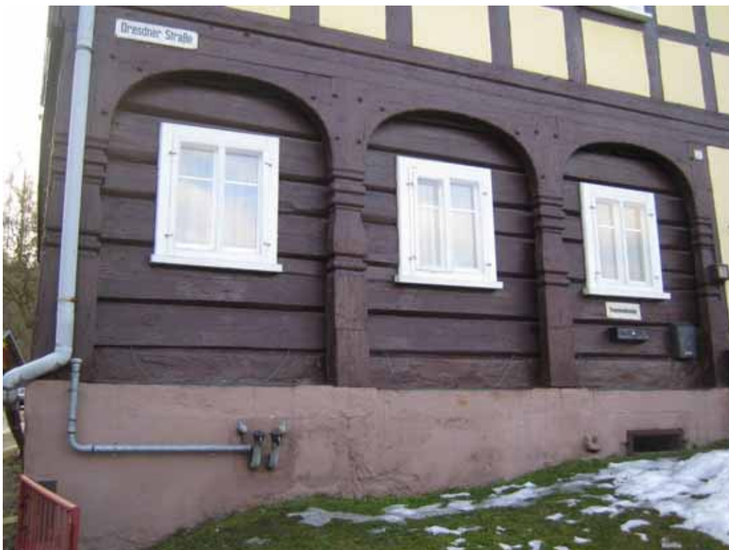
Detailaufnahme des Gebäudes.
