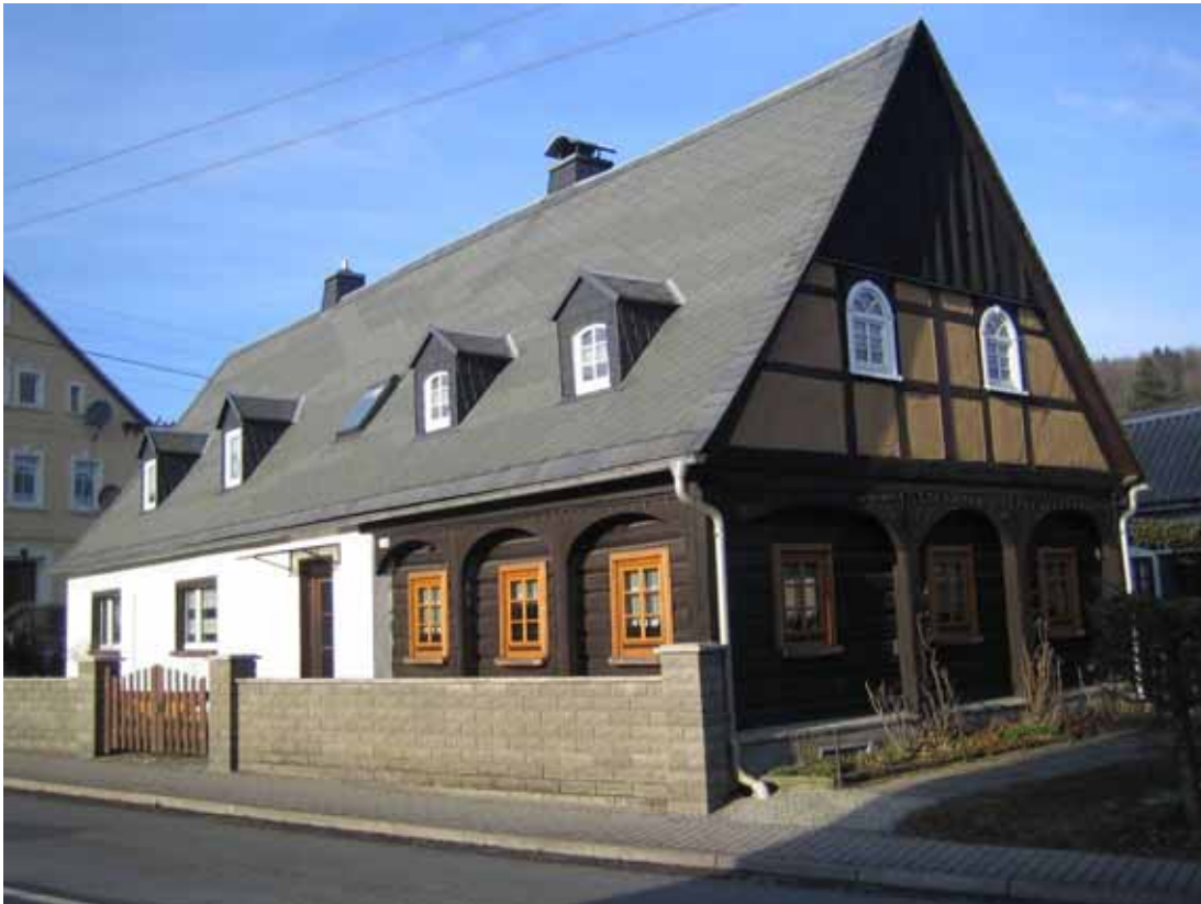
Wehrsdorf, Umgebinde, hervorragend mit offenporiger Öllasur behandelt und vor Straßeneinflüssen mit einer Granitmauer geschützt, da durch Spritzwasser und Salze stark gefährdet.
