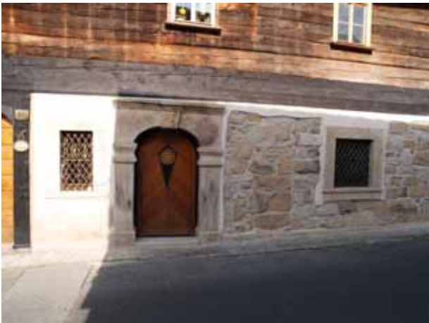
Foto 15. Beispiel einer gut durchgeführten Instandsetzung
