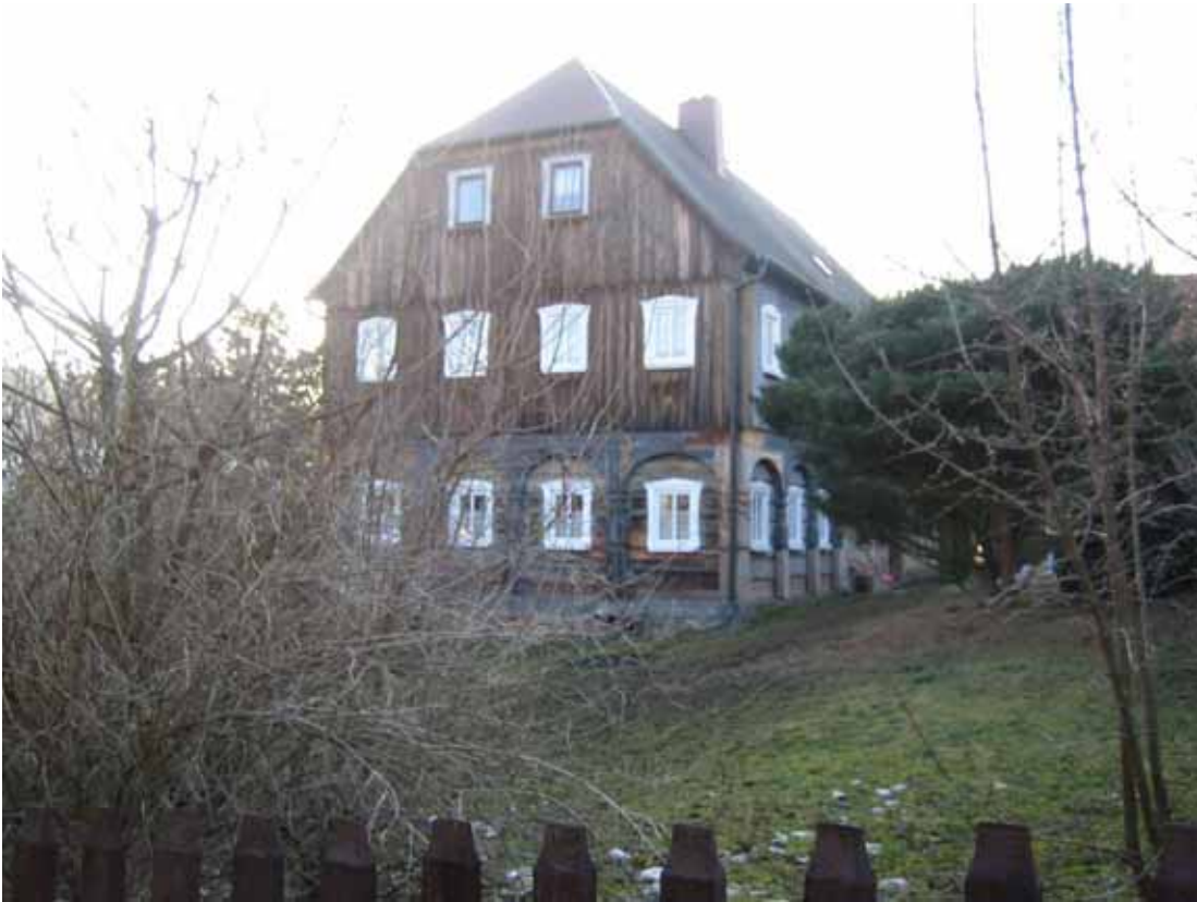
Gebäude in diesem Zustand lassen sich auf Naturölbasis hervorragend restaurieren.
