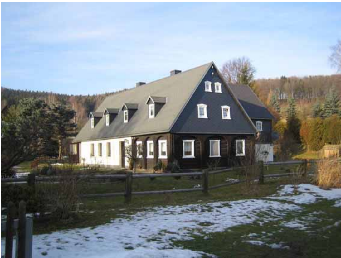
Wehrsdorf, mit offenporiger Öllasur vor 20 Jahren behandelt und immer noch intakt.
