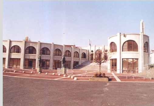
Abb. 95: Haupteingang Stade annexe
