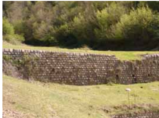
Masa mbrojtëse anti erozive :Ndërtimi i pritave Hogosht 2007
