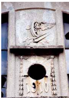
Detail vom 1999 abgerissenen Depot Hamborn am Schlachthof
