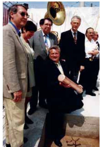
Grundsteinlegung für die neue Werkstatt: Dirk Lachmann, Vorsitzender des DVG-Aufsichtsrates, OB Bärbel Zieling, Vorstände Uwe Steckert, Dr. Edmund Baer (mit Rolle), Klaus Siewior (von links nach rechts)
