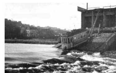
... andere nicht. (Ruhrbrücke Herbede mit Straßenbahn der Bogestra am 13. Januar 1947)
