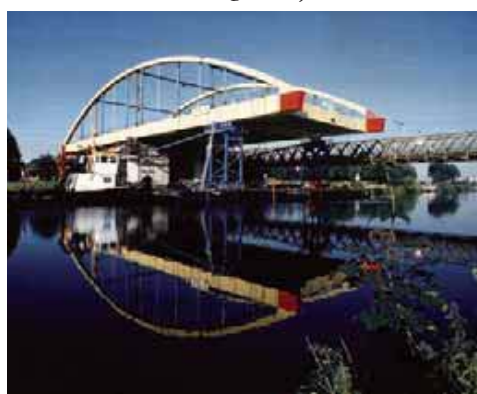
Montage der neuen Brücke, im Hintergrund die Behelfsbrücke
