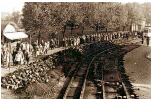
Umspurung – rechts liegt schon das neue Gleis
