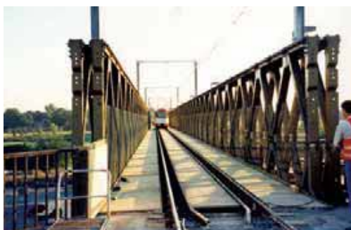
Behelfsbrücke für die Straßenbahn
