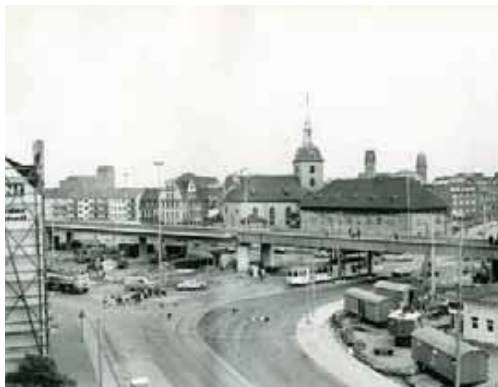
Bau Hochstraße und Kreuzung am Marientor 1971
