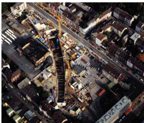
Hausunterfahrung Hedwigstraße: Schacht und offene Baugrube auf dem Gelände des ehemaligen Betriebshofes der DVG
