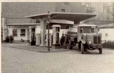
1929: An der Ecke Tomhallen-/Friedrich-Wilhelm-Straße gibt es neuerdings eine Tankstelle.
