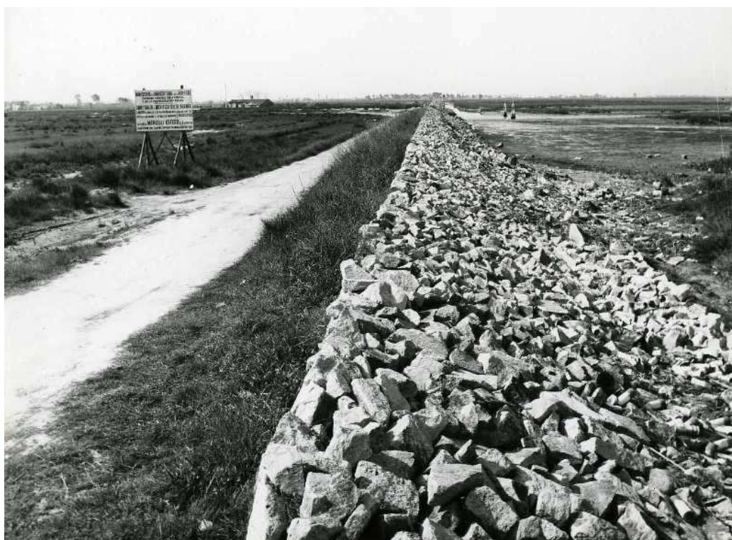
8 - Valli – lavori di rialzo dell'argine di difesa lagunare Consorzio di bonifica Delta Brenta, anni Sessanta (foto Biblioteca Civica Sabbadino)
