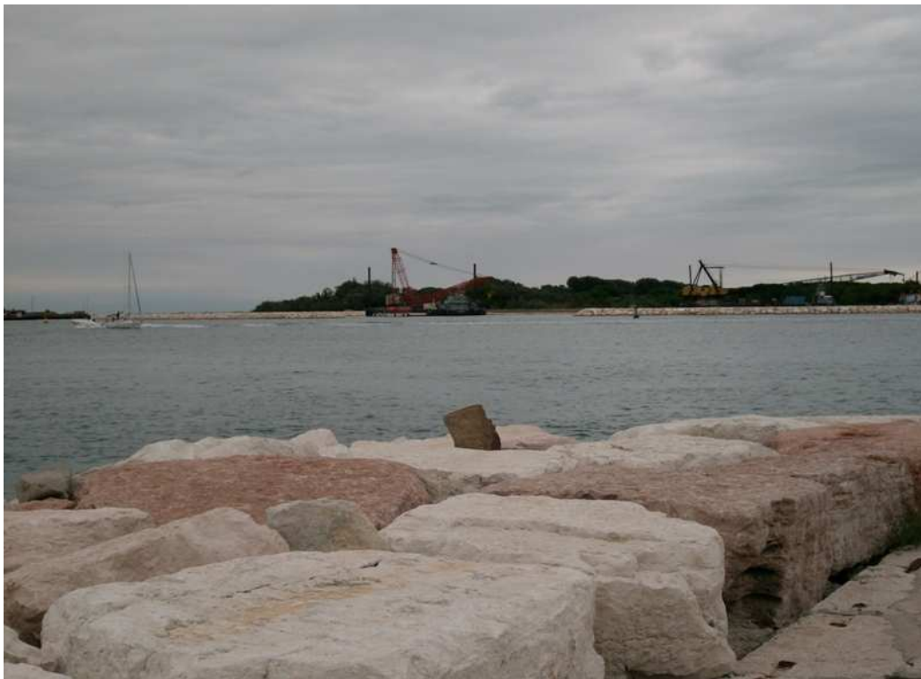
29 – Sottomarina. Molo foraneo e sullo sfondo il cantiere per il MoSE a Ca' Roman, 2008 (foto dell'autore)
