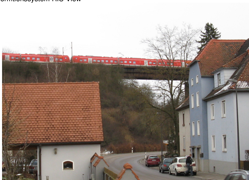
Blick auf die Talbrücke vom Ortskern aus in Richtung Nordosten
