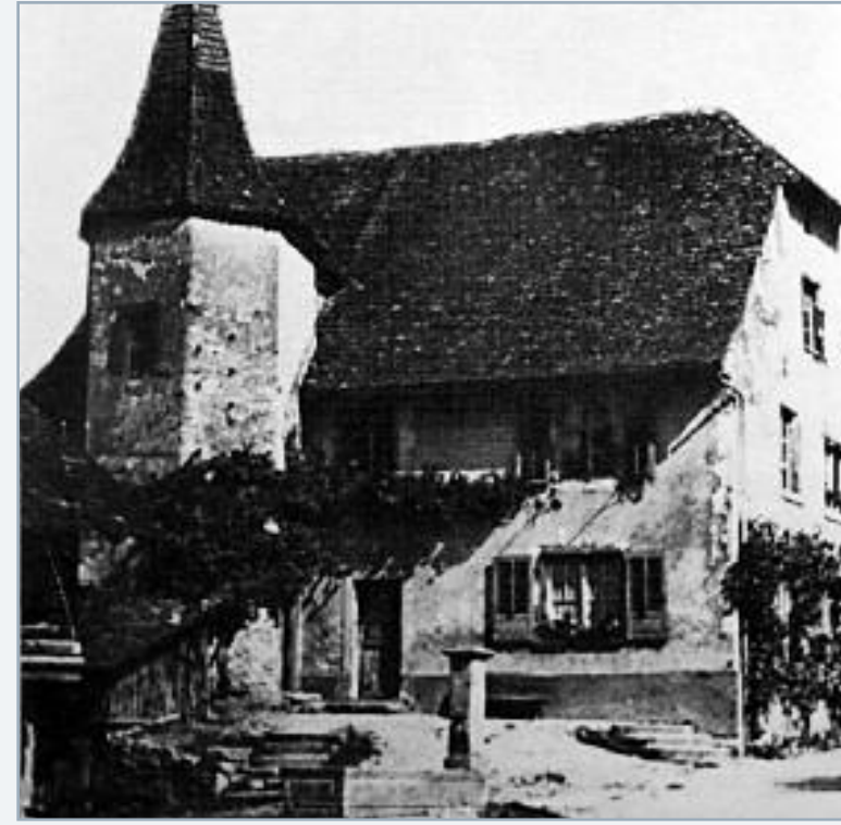
Das Schönauer Schlässchen in Oeschgen vor der Renovation
