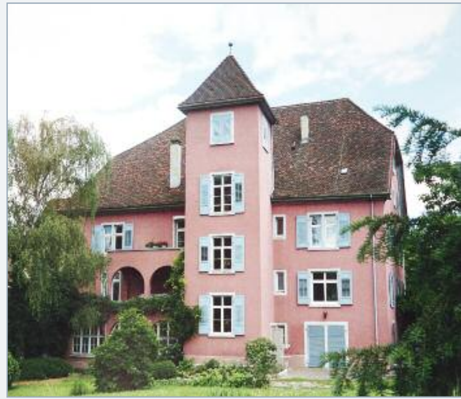
Der Schönauerhof in Rheinfelden (CH): Ansicht von Westen
