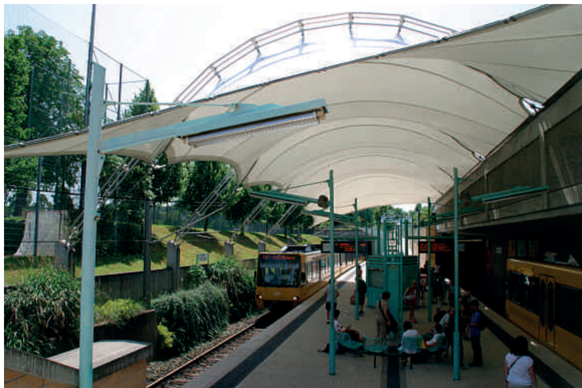
Ungewöhnliche Lösung bei der Sporthaltestelle Waldau (1998, Architekt Unold und Partner): Die oberirdisch vorhandene Anliegerstraße erforderte eine einseitig überdeckende Auskragung. Diese geht optisch in ein großes Zelt-dach über (Planung: Schlaich, Bergermann und Partner), das gleichzeitig Sonnen- und Regenschutz für den Bahnsteig bildet. Die Anregung gab die Bauweise im damaligen Daimlerstadion. So entstand trotz der Lage direkt zwischen den zwei Tunneln Waldau und Ruhbank eine anregende Atmosphäre.
