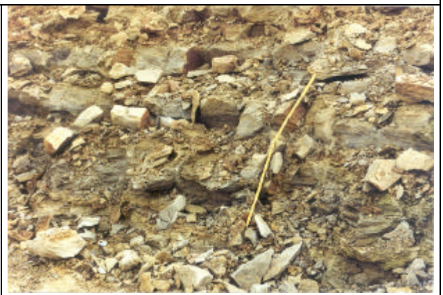
Trennflächenbedingtes Lösen des Festgesteines der Kreide (Pläner, Mergel und Sandsteine).
