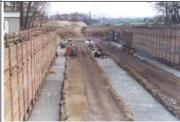
Einbringen einer Ausgleichsschicht aus Beton für den Aufbau der Fundamente (Blick nach Osten).
