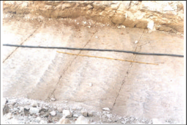
Vorbereitung der Sohle des Einschnittes für die Gründung der Streifenfundamente des Tunnelbauwerkes in den Kreidegesteinen.
