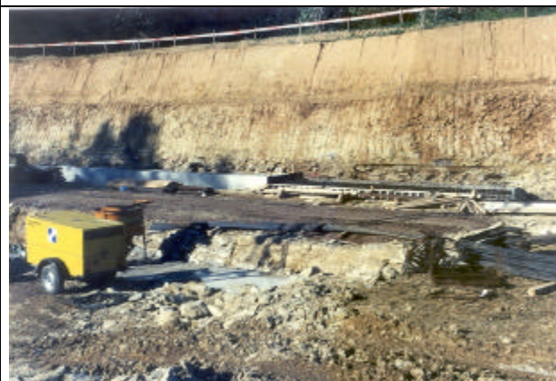
Aufschlußprofil mit der Schichtenfolge: Mutterboden (Hangendes), Ghl, Ghsch, Kreide (Liegendes), Gesamtmächtigkeit ca. 8 bis 10m, Wandstreichen ca. West-Ost.
