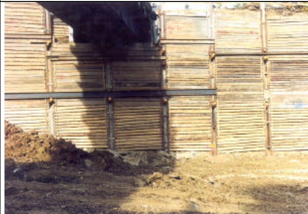
Böschungssicherung des Einschnittes mittels Berliner Verbau und zusätzliche Sicherung des Verbaus mittels Litzentanker (Bild rechts).
