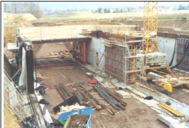
Bau der Tunnelröhren am Ostende des Einschnittes - stadtwärtiges Tunnelportal (Blick nach Osten).
