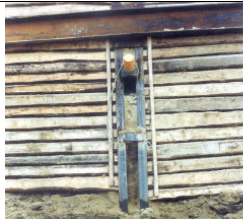
Böschungssicherung des Einschnittes mittels Berliner Verbau und zusätzliche Sicherung des Verbaus mittels Litzentanker (Bild rechts).
