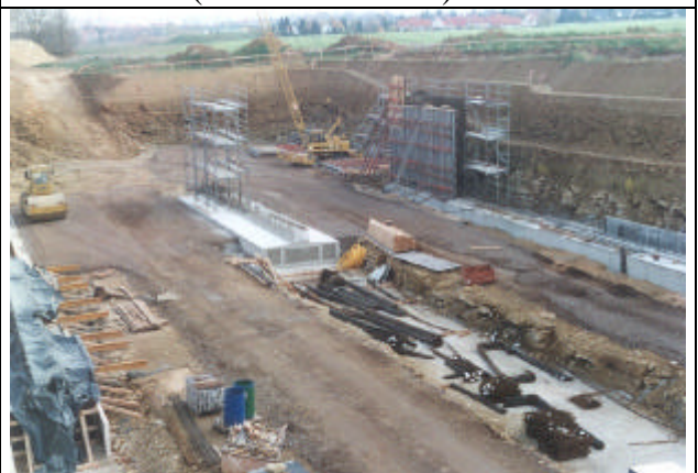
Fundamentierungsarbeiten am Ostende des Einschnittes und erste Schalungsarbeiten für die Tunnelröhre (Blick nach Osten).
