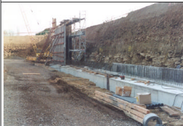
Fundamentierungsarbeiten am Ostende der südlichen Fundamentgrube des Einschnittes. Im Hintergrund erste Schalungsarbeiten für die Tunnelröhre (Blick nach Osten).
