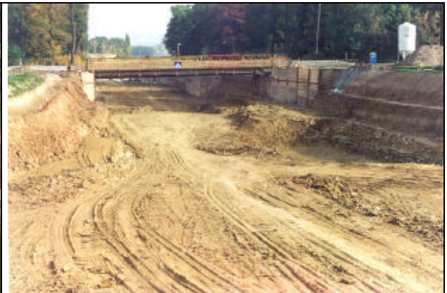
Herstellung des Einschnittes für die offene Bauweise (Blick nach Osten) mit den Behelfsbrücken für Fußgänger und Kraftfahrzeuge.
