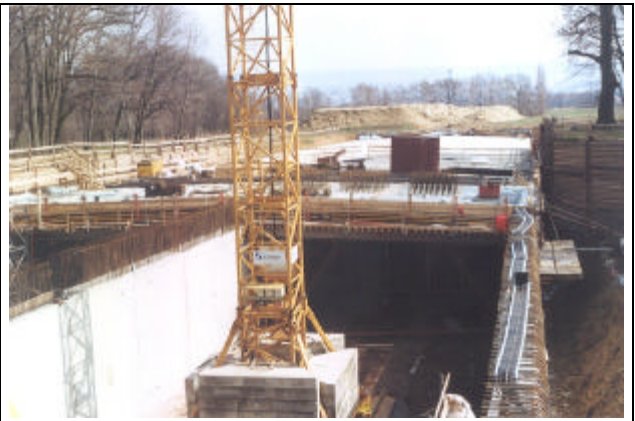
Stand der Bauarbeiten am 1. April 2001, Blick auf die Tunnelröhren von der Fußgängerbrücke in Richtung Elbtal (nach Osten).
