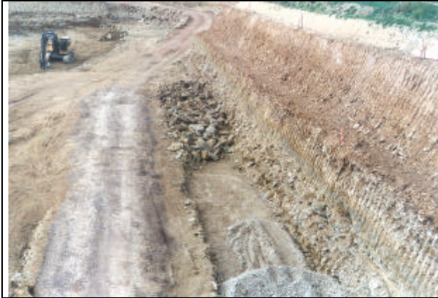
Vorbereitung der Sohle des Einschnittes für die Gründung der Streifenfundamente des Tunnelbauwerkes in den Kreidegesteinen.
