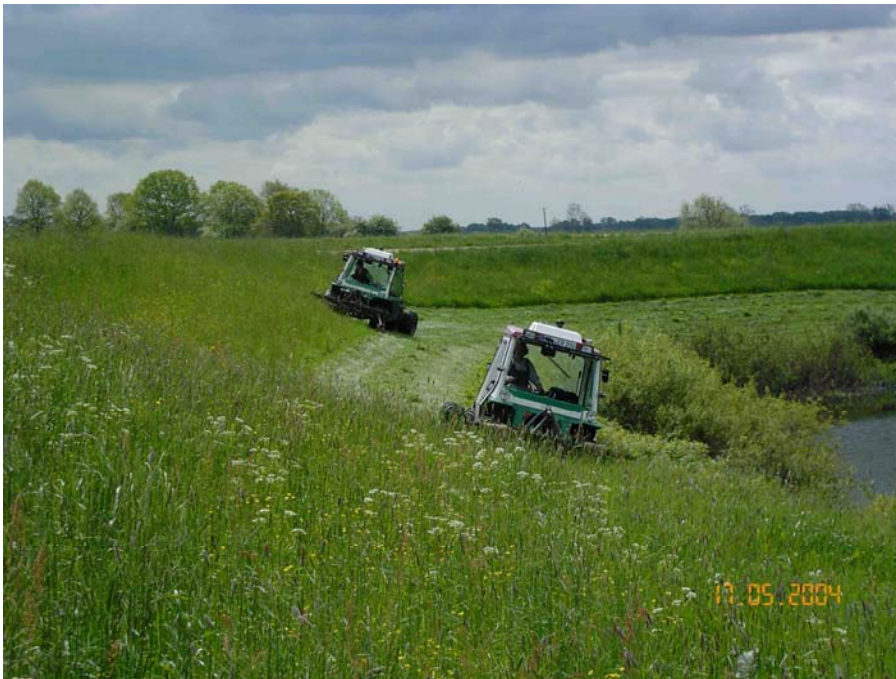
Bild 11: Deichunterhaltung mit Mähtechnik
