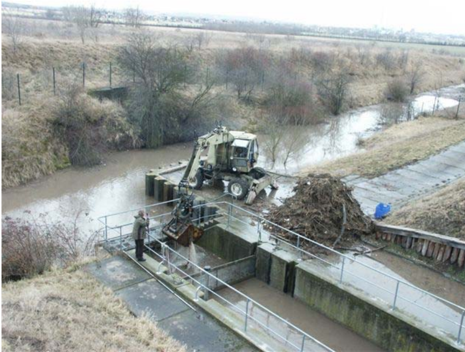
Bild 12: Beräumung am Pumpwerk Wansleben
