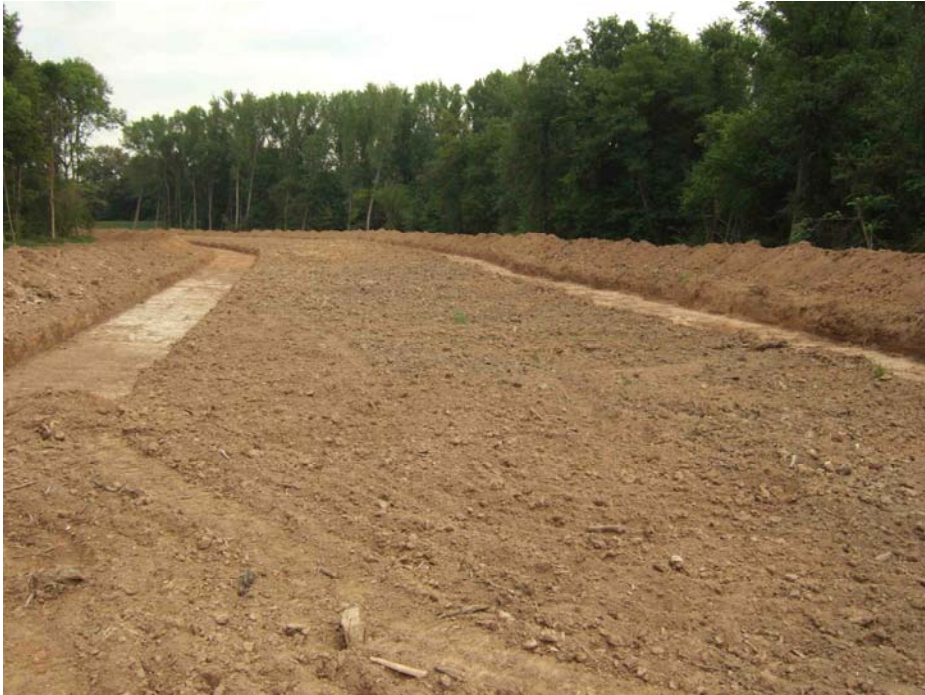
Bild 1: Vorbereitung der Deichtrasse der DRV Lödderitz
