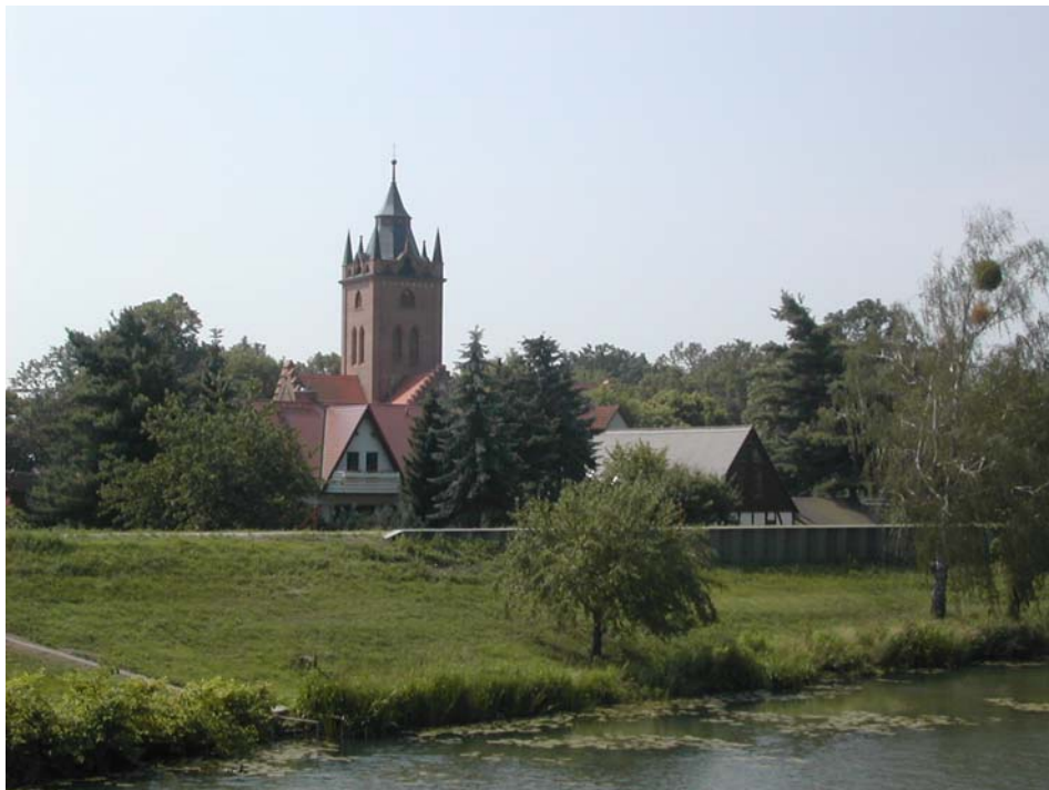
Bild 3: Freistehende Spundwand in Dessau-Mildensee
