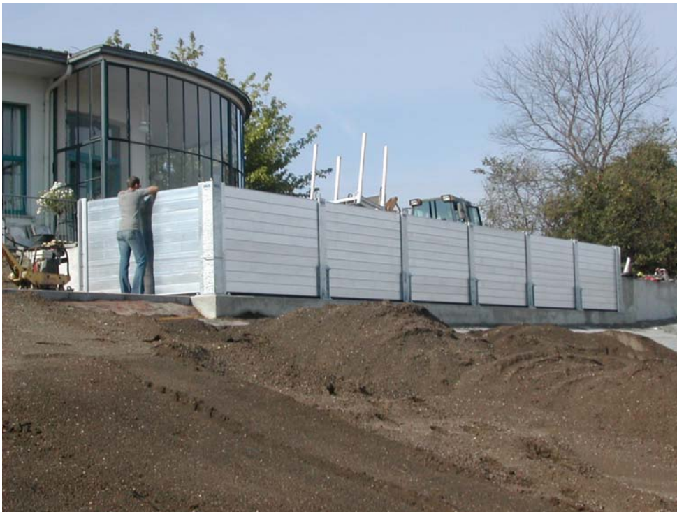
Bild 5: Probeaufbau der mobilen Hochwasserschutzwand am Kornhaus in Dessau
