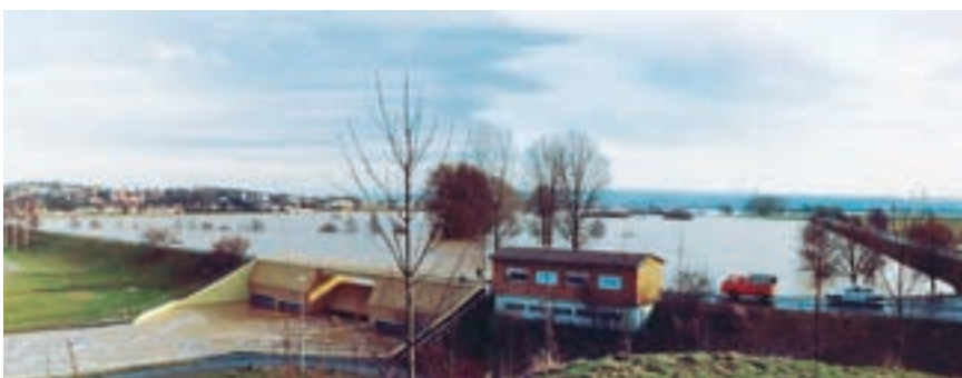
Abbildung 1: Hochwasserrückhaltebecken Treysa im Schwalm-Eder-Kreis
