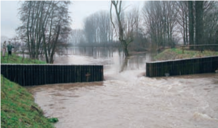
Abbildung 16: aktivierter Retentionsraum Groß – Zimmern an der Gersprenz [Wasserverband Gersprenzgebiet]
