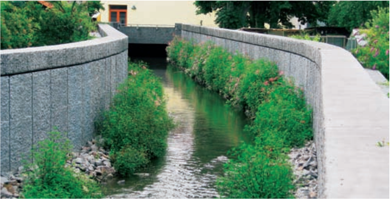
Abbildung 21: Neue Hochwasserschutzmauer entlang der Rodau in Mühlheim am Main
