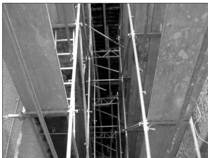
Blick auf den zurzeit kompliziertesten Bauabschnitt zwischen Westflügel und Saalanbau
