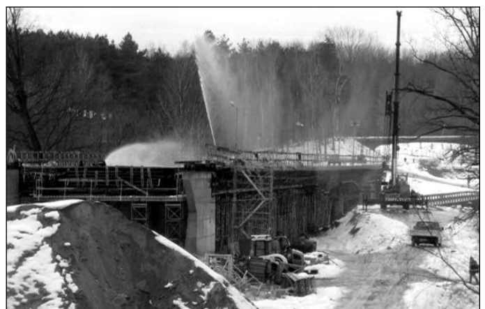
Winter auf der Baustelle - Januar 2011
