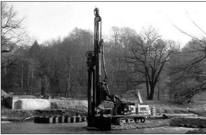
Vorbereitung der Pfeilergründung März 2011
