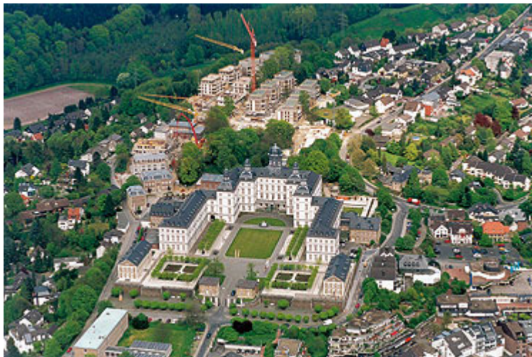
Das Grandhotel Schloss Bensberg aus der Luft, die Service-Residenz dahinter im Bau, 2001
