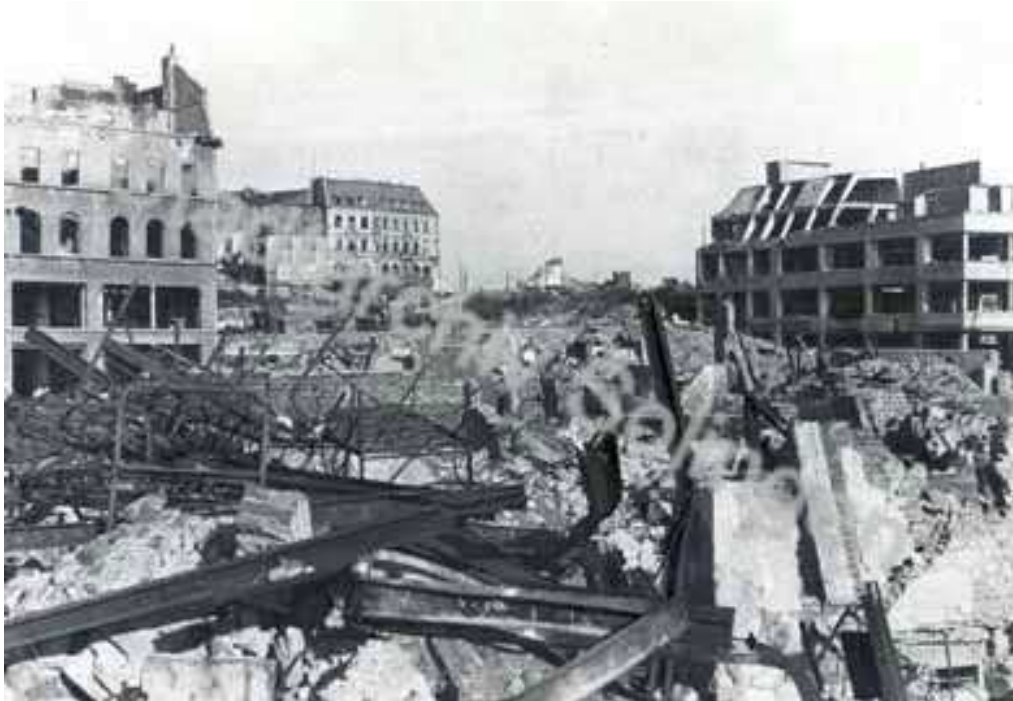
Trümmerlandschaft. Blick von der Malteserstraße in Richtung Graf-Wilhelm-Platz. In der Bildmitte das Gebäude Tüchtmantel
