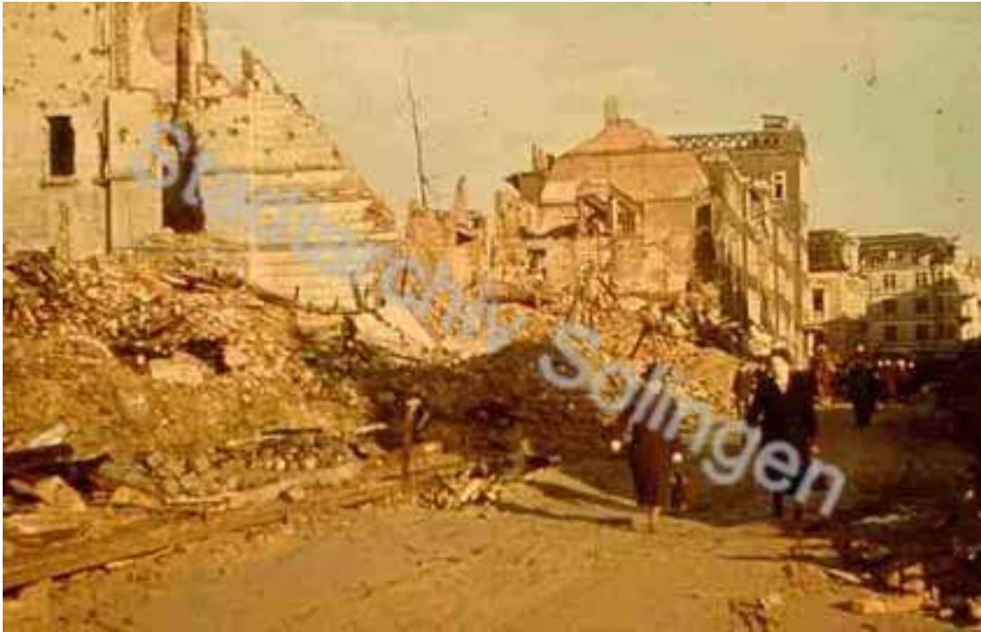
Als erster Großbau der Innenstadt soll das Gebäude der AOK und des Spar- und Bauvereins in der Kölner Strasse wieder hergestellt werden
