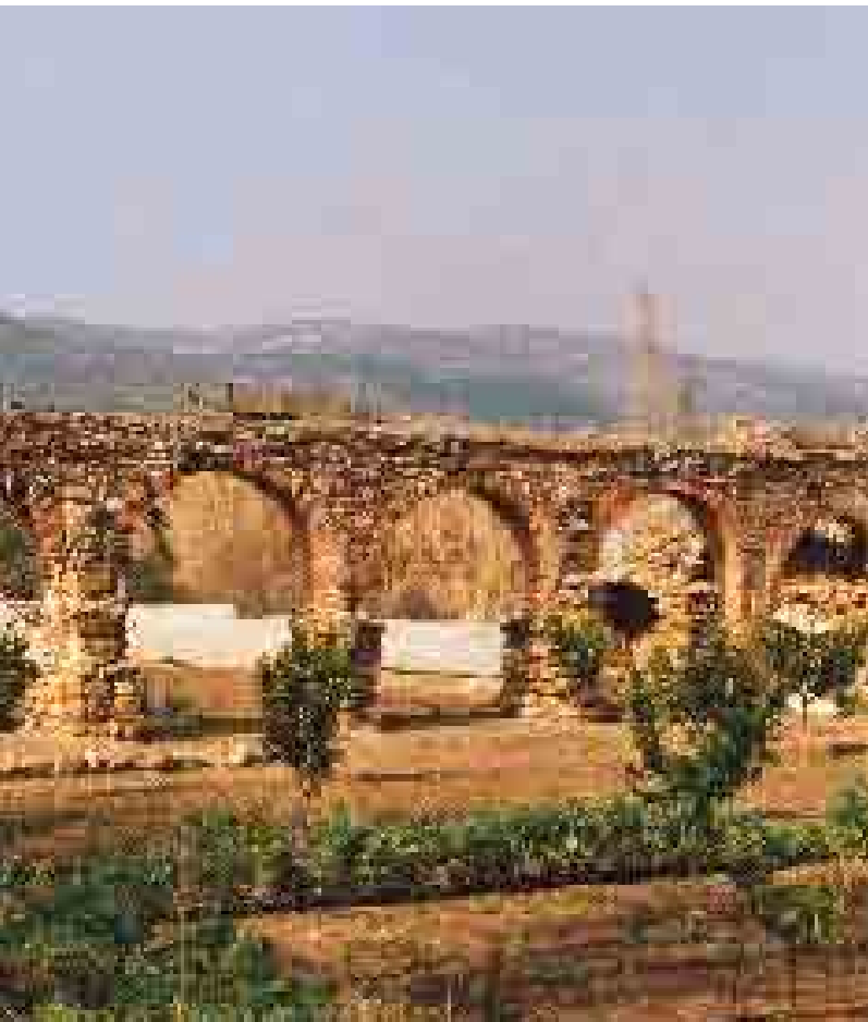
Plataforma circular sobre la que se sitúa la noria y arcos de medio punto sobre los que se canalizaba el agua
