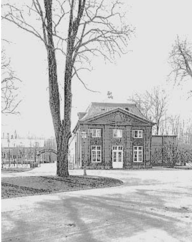
Ansicht des Pavillon D, Wohnsitz Bouchés von Nordosten, Aufnahme 1898.
