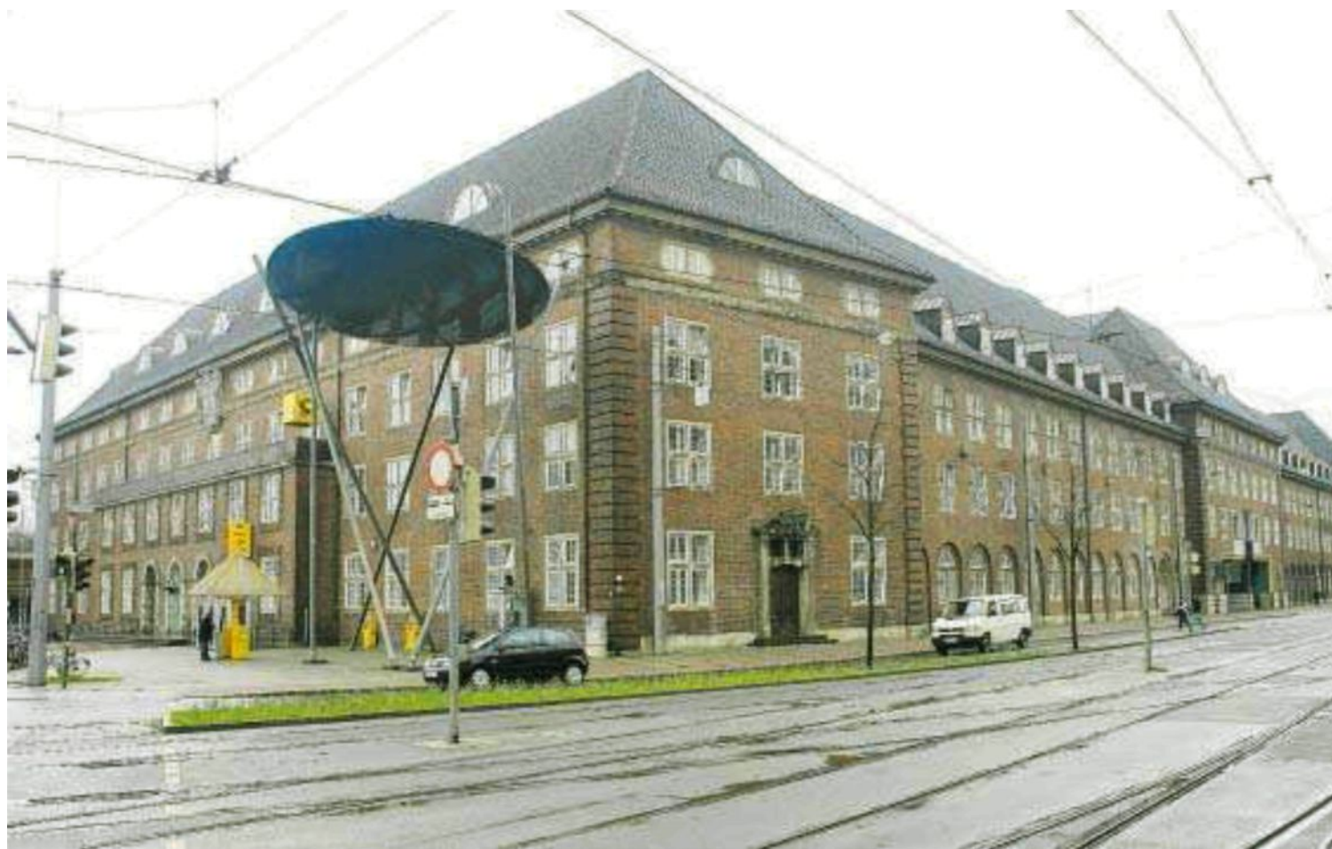
Elegante Borgward-Limousinen, historische Straßenbahnzüge - wäre dies das richtige Innenleben für das Postamt 5 am Hauptbahnhof? Es gibt jetzt den Vorschlag, aus dem Gebäude mit den vielen leeren Flächen ein „Haus der Museen“ zur bremischen Geschichte zu machen. FOTO: STOSS
