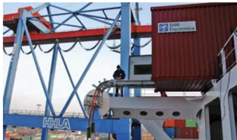
Landanschlüsse statt laufender Hilfsdiesel
