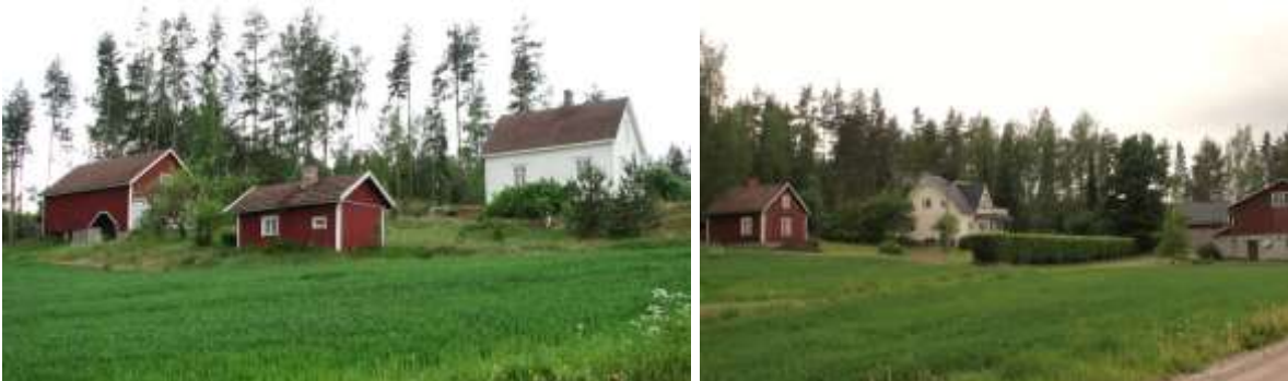
Kuvat: Kuvassa vasemmalla on Pakkalan pihapiiriä, missä pieni 1930-luvun asuinrakennus on pitkälti alkuperäisessä asussaan. Oikealla on Liljan 1930-luvun alussa valmistunut päärakennus, jonka ulkoasussa on kerroksellisuutta.
