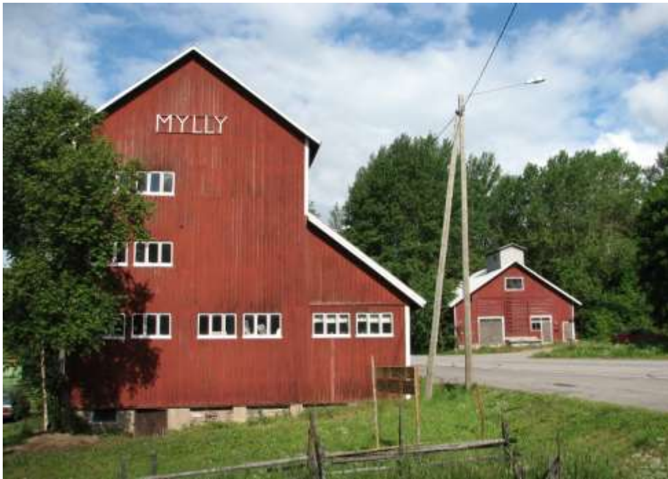
Kuva: V. Mattilan perustama valssimylly ja Sälinkää Oy:n kyläkuivuri.
