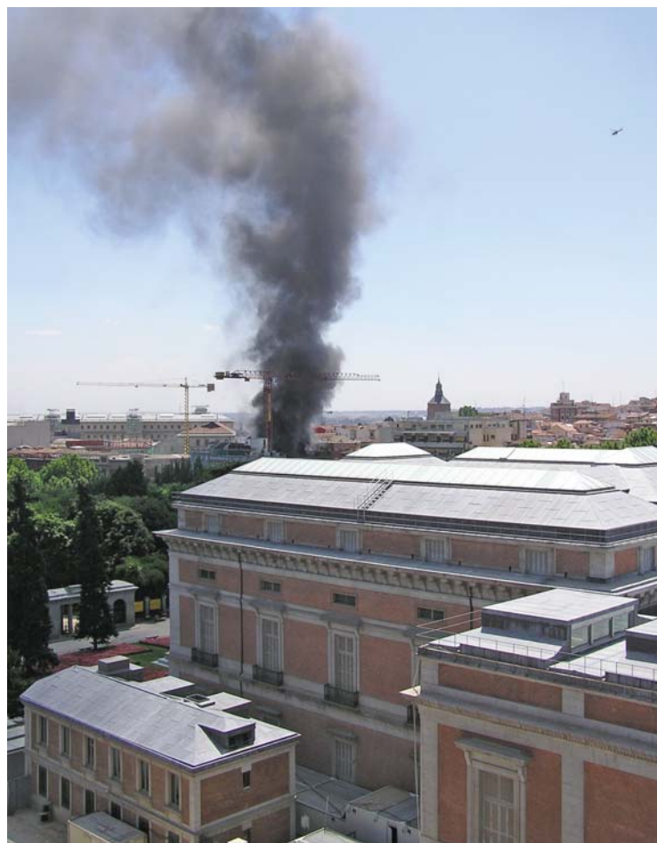
7. La columna de humo del incendio de la Subestación Eléctrica de Atocha tras el edificio del Museo Nacional del Prado y cerca del Museo Nacional Centro de Arte Reina Sofía, 15 de julio de 2004 (Foto: Archivo particular M.H.A.).
