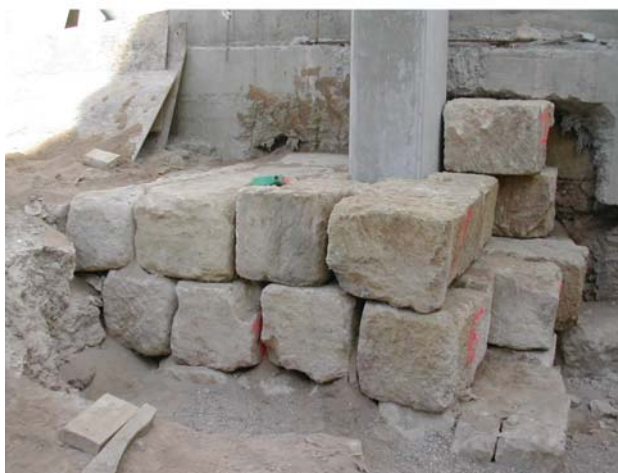
8. Integración de encepados en los restos arqueológicos (Foto: Joaquín Lizasoain, Pau Soler y Gonzalo Tello).
