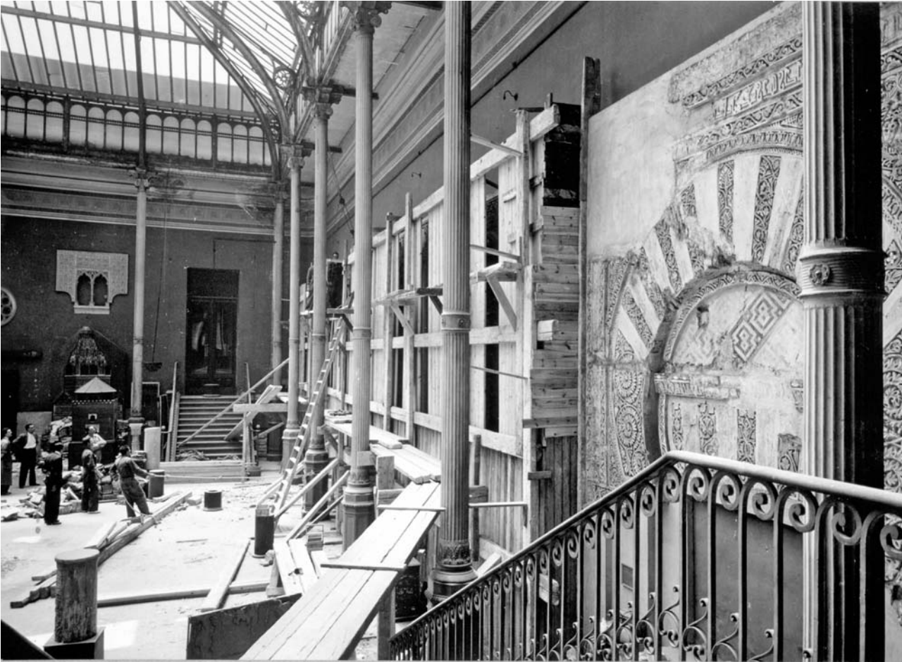
6. Evacuación de piezas con dificultades derivadas del elevado peso y del sistema de anclaje al muro. Desmontaje de yesería árabe del Museo Arqueológico Nacional (Foto: Museo Nacional del Prado).
