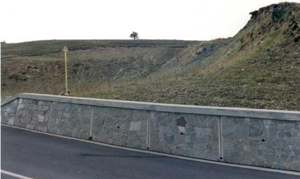
Scavi lungo la strada per i Piani di Praglia
