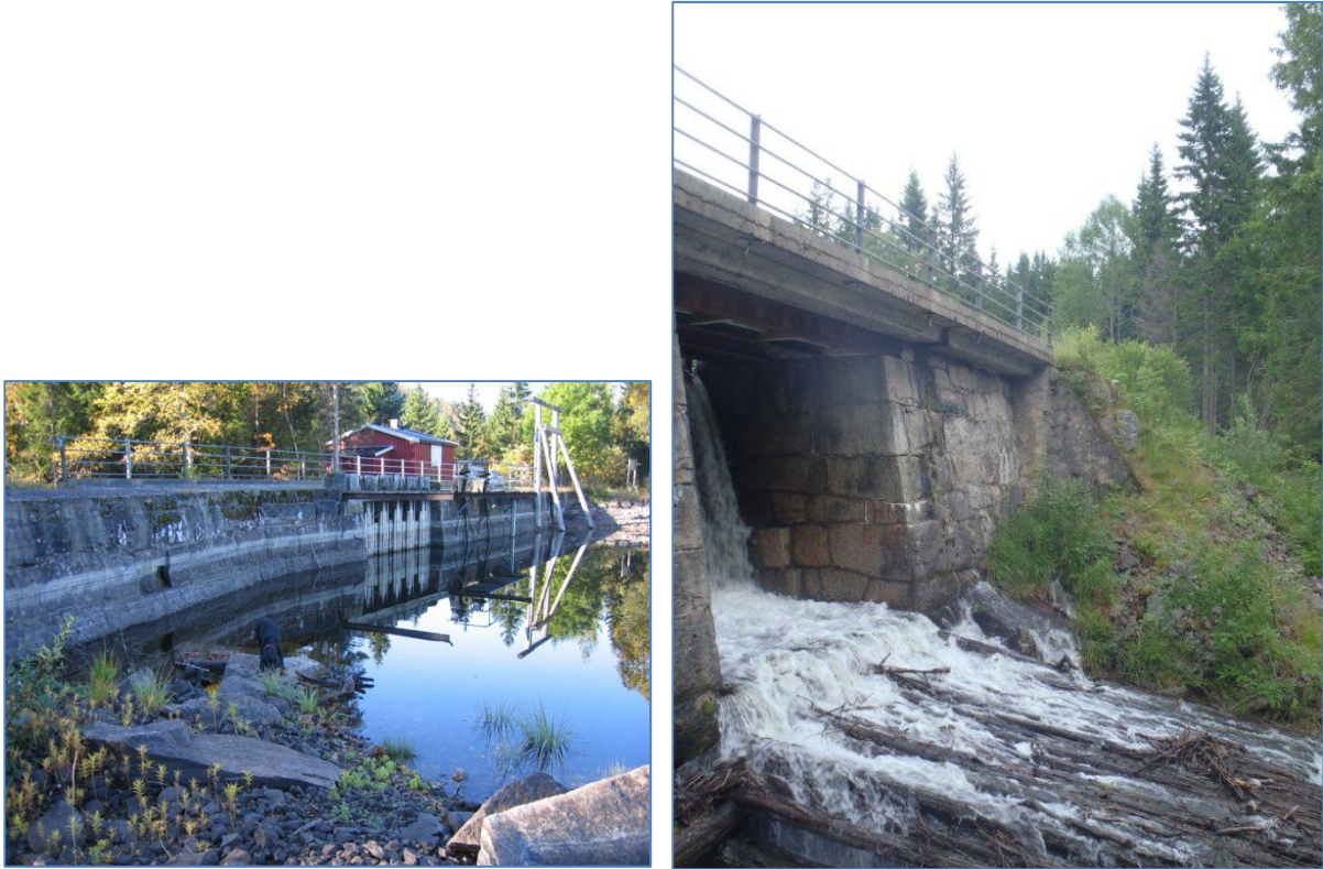
Figur 132. Dammen i utløpet av Helgeren sett ovenfra (venstre panel) og nedenfra (høyre panel). Foto: VAV.
