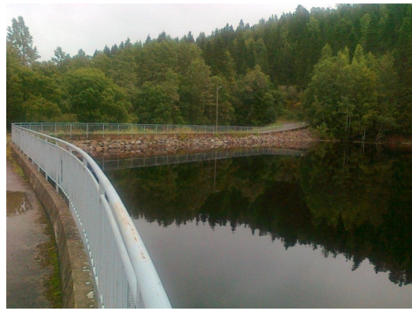
Fra oppstrømsiden av dammen
