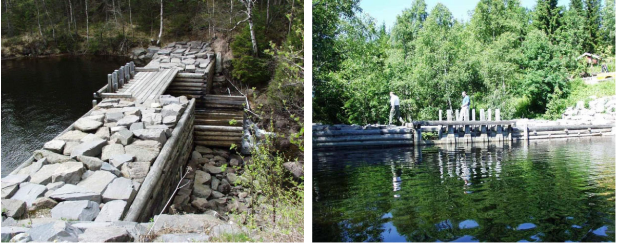
Figur 126. Utløpsdammen fra Store Gørja. Foto: VAV.
