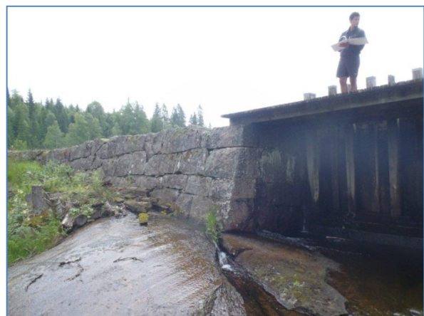
Figur 124. Fra dammen ut av Kalvsjøen, til venstre overløpet ved HRV, og til høyre fløtningsdammen med tappeanordning for fløtningsvann. Foto: VAV.
