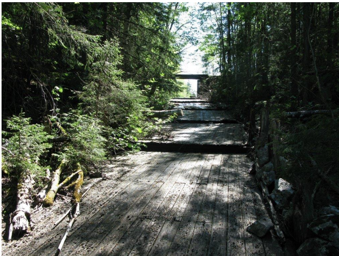
Figur 100. De øvre 50-100 m av Smalvannsbekken er dekket med skottbruer som skal hindre at tømmeret satte seg fast. Bekker renner i naturlig leie under broene og det ser ut til at fisk kan passere. Foto: VAV.
