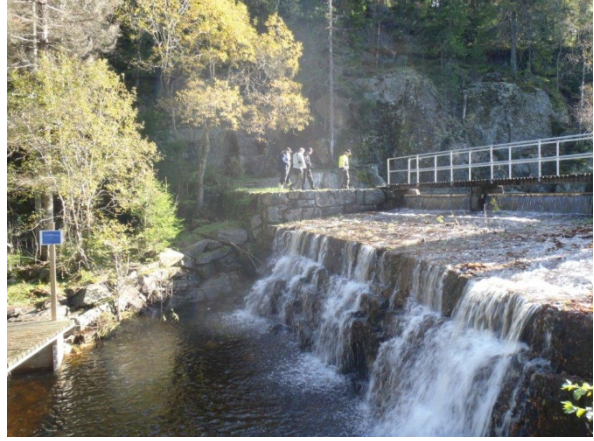
Dammen med overløp sett nedenfra en dag det er overløp
