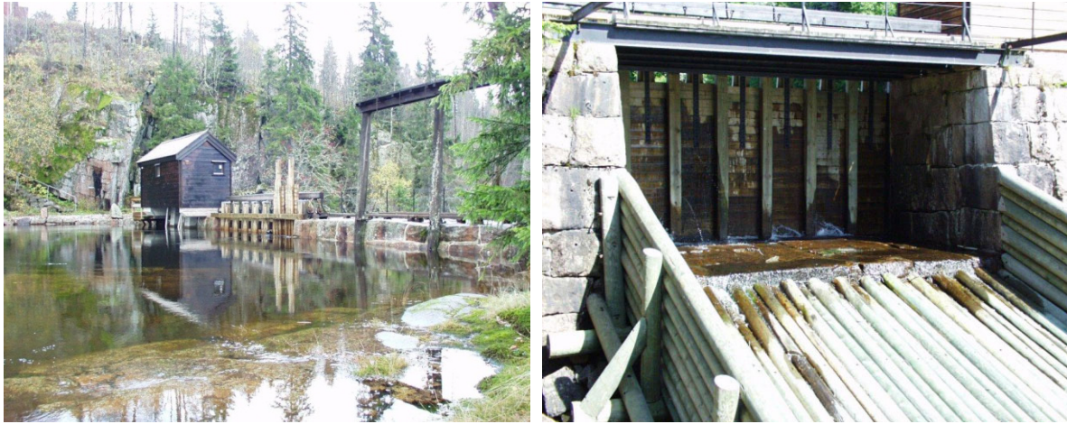
Figur 113. Dam i utløpet av Bjørnsjøen med tappeanordning. Overløp på hver side av tappeanordningen. Foto: VAV.
