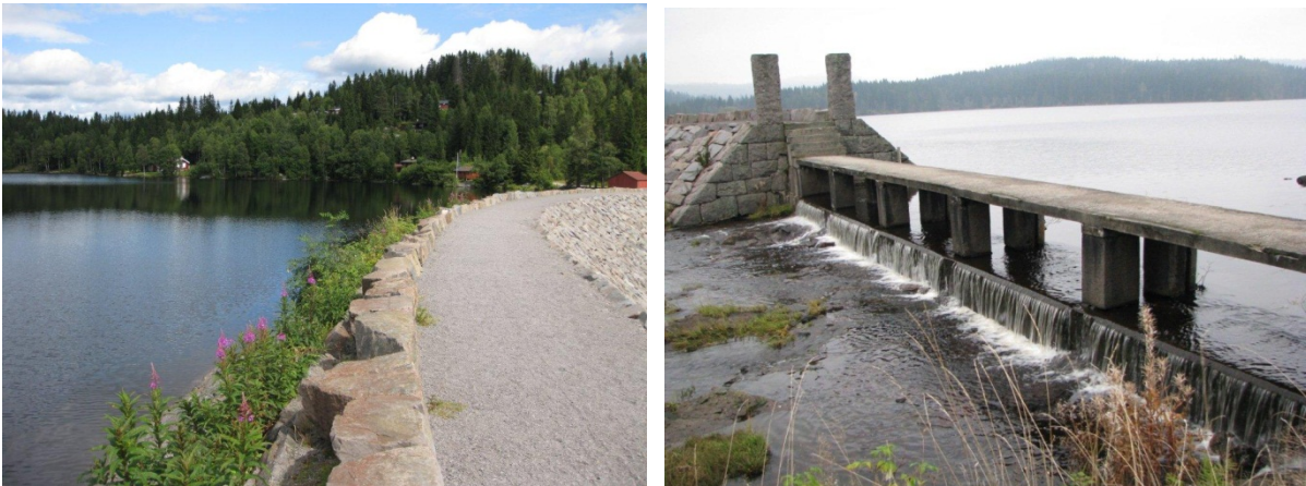
Figur 149. Ørfiske dam med overløpsanordning. Innsjøoverflaten står for det meste ca. 0,6 m under HRV (overløpets høyde). Det slippes ikke noen minste vannføring til Ørfiskebekken, og i perioder med liten avrenning er denne tørr. Foto: VAV.
