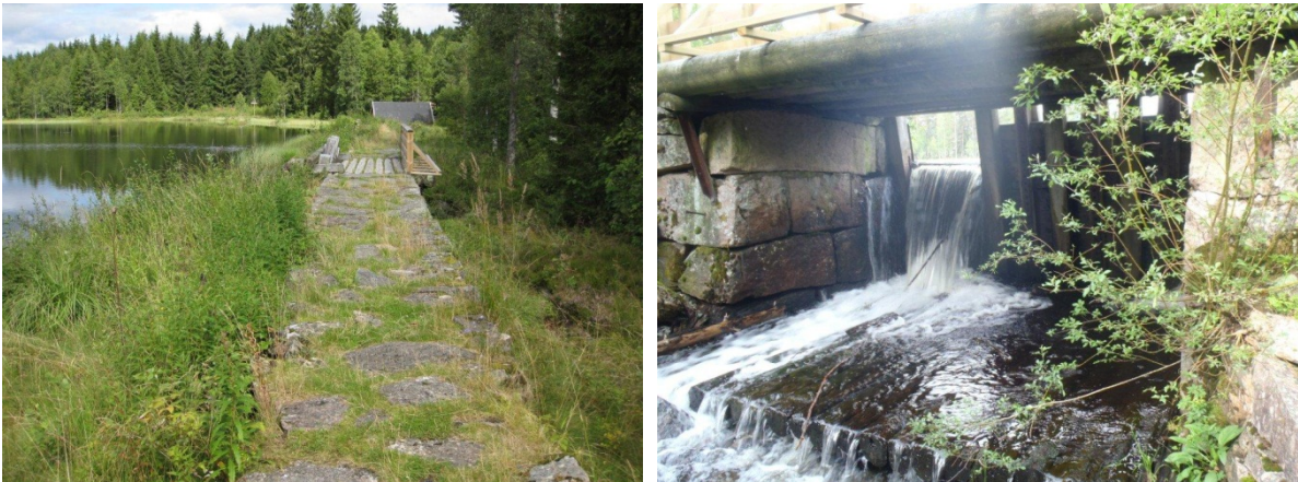
Figur 138. Dammen i utløpet av Rottungen og tappeanordningen (fløtningsdam). Foto: VAV.
