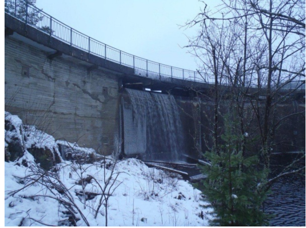
Dammen sett nedenfra
