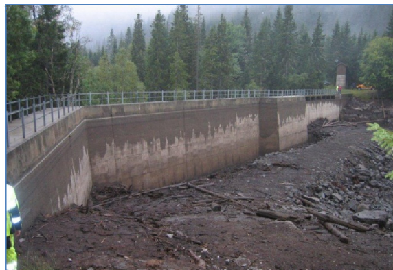
Fra august 2012. Vannstanden tappet ned som følge av reparasjoner på dammen
