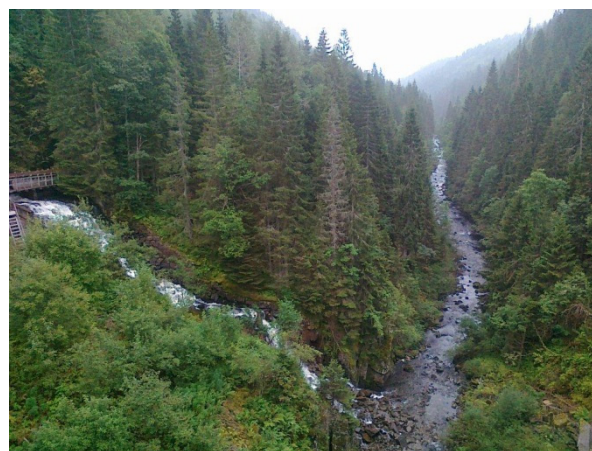
Overløpet munner ut i Langlielva nedenfor dammen. Like nedenfor der overløpet munner ut, men på høyre side av elva, munner avløpet fra bunnventilen i dammen ut, der minstevannføringen ble tappet fra da innsjøen var tappet ned under HRV.
