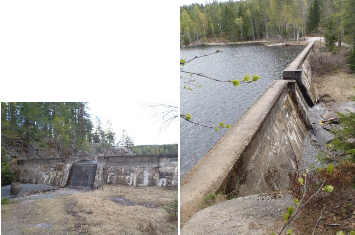
Figur 169. Dam ved Romstjern med flomoverløp. Foto: VAV.
