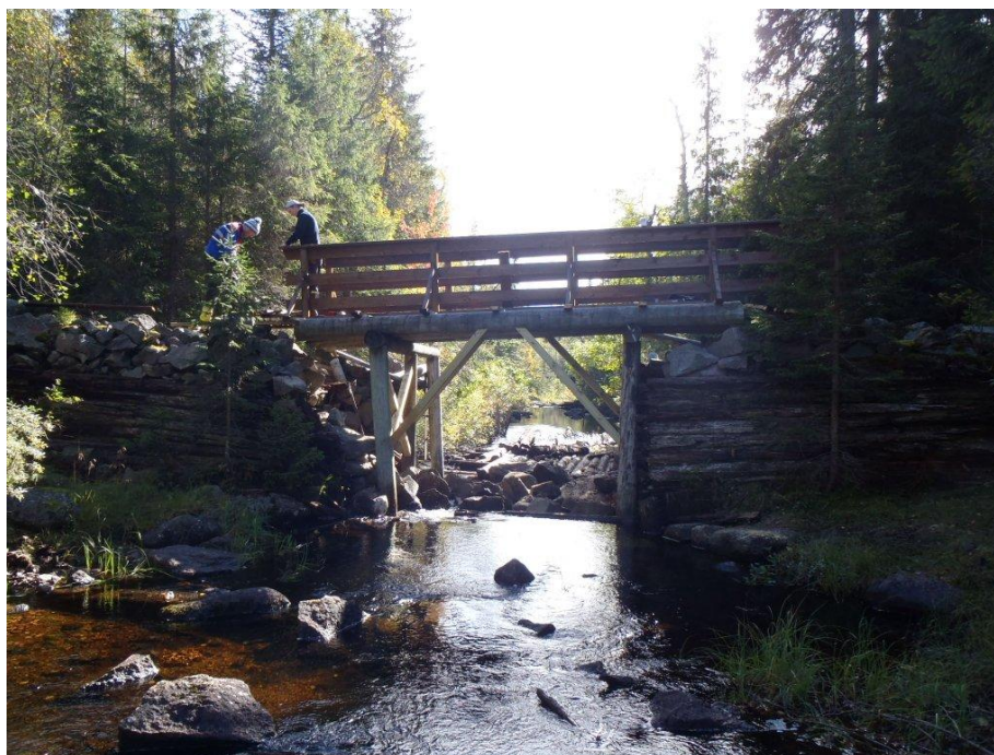
Figur 3. Sinnerdammen, en gammel steinkistedam der reguleringsinnmaten er fjernet og dammen står åpen på laveste regulerte vannstand (LRV). Foto: VAV.
