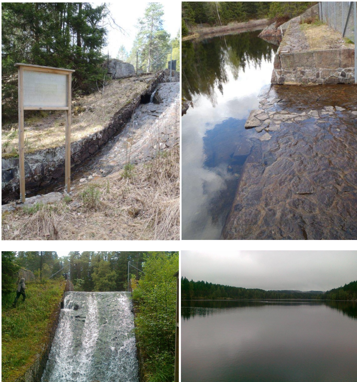
Figur 165. Breisjøen dam og utløp. Bildet nederst til høyre er innsjøen sett fra dammen. Foto: Dag Berge.
