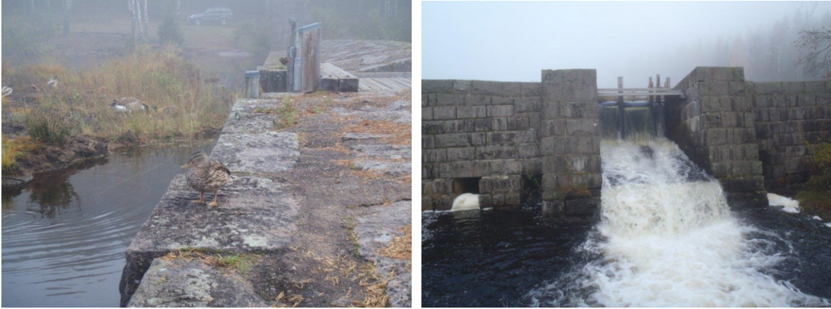
Figur 144. Dammen i utløpet av Øyungen med flomløp. Foto: VAV.
