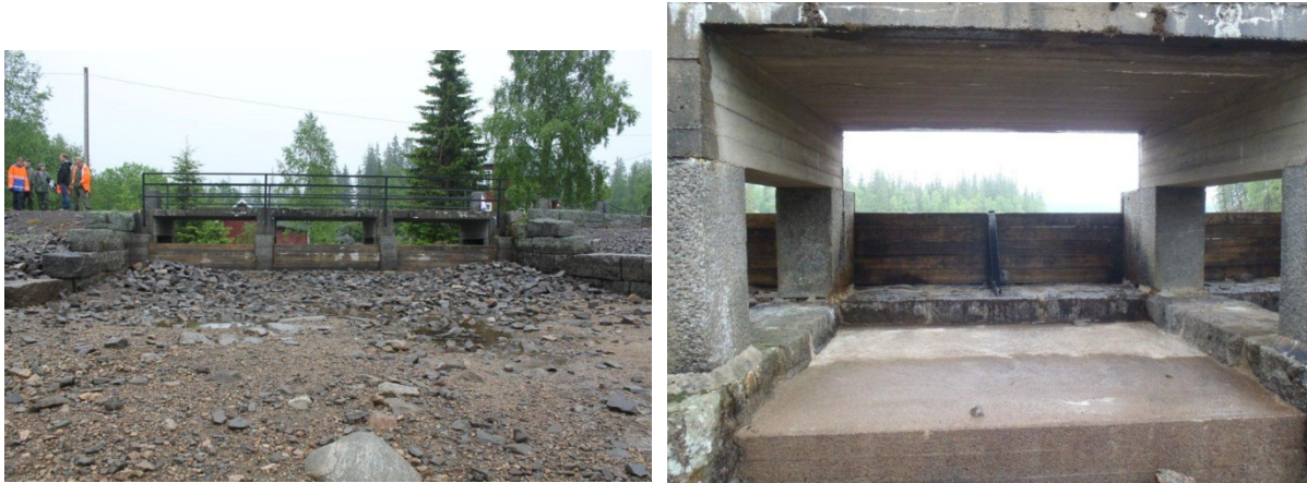
Figur 80. Gjerdingen dam. Til venstre sett fra Gjerdingen i nedtappet tilstand. Til høyre dammen sett nedenfra. Normalt slippes det ikke vann til Gjerdingselva, som da for det meste er tørr ved utløp Gjerdingen. Foto: VAV.
