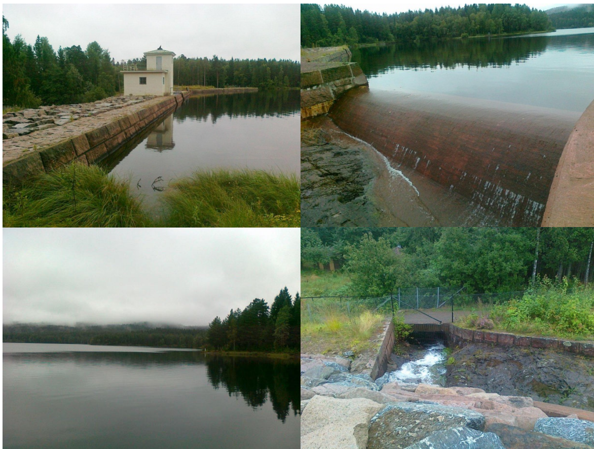
Figur 167. Dammen ved utløpet av Alnsjøen med hus for regulering av bunnluker, til høyre flomoverløp, nederst til venstre fra dammen og utover innsjøen, nederst til høyre ses utløpselven nedenfor dammen. Foto: Dag Berge.
