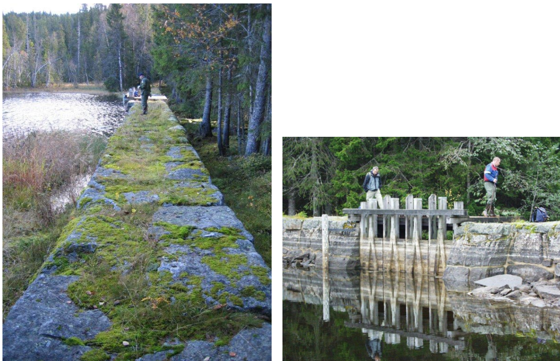
Figur 68. Dammen på Store Fyllingen men utløpsanordning. Foto: VAV.
