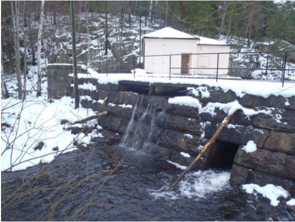
Dammen sett nedenfra med vannslipp fra bunnluke
