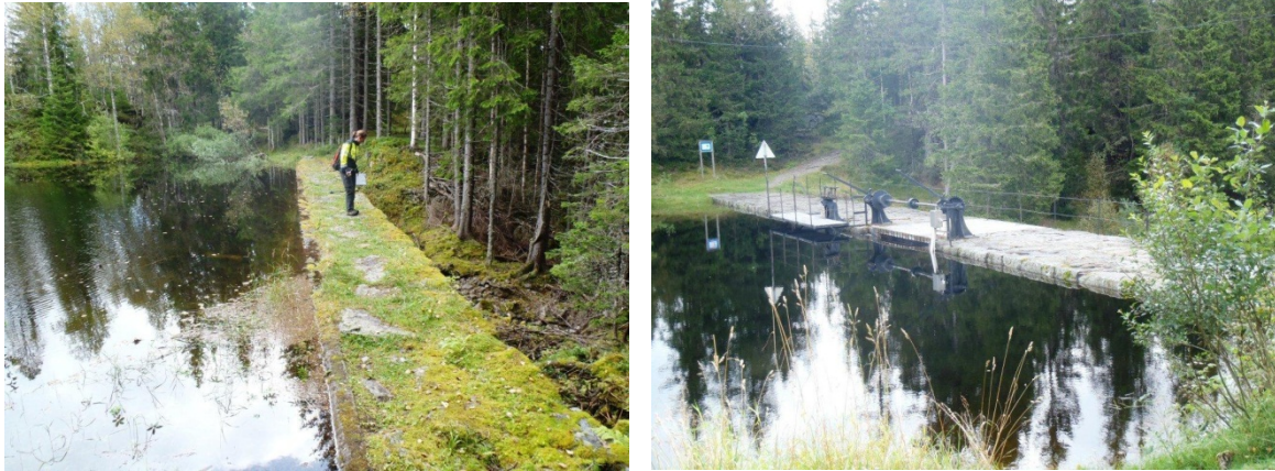
Figur 64. Katnosa dam med utløpsanordning. Foto: VAV.
