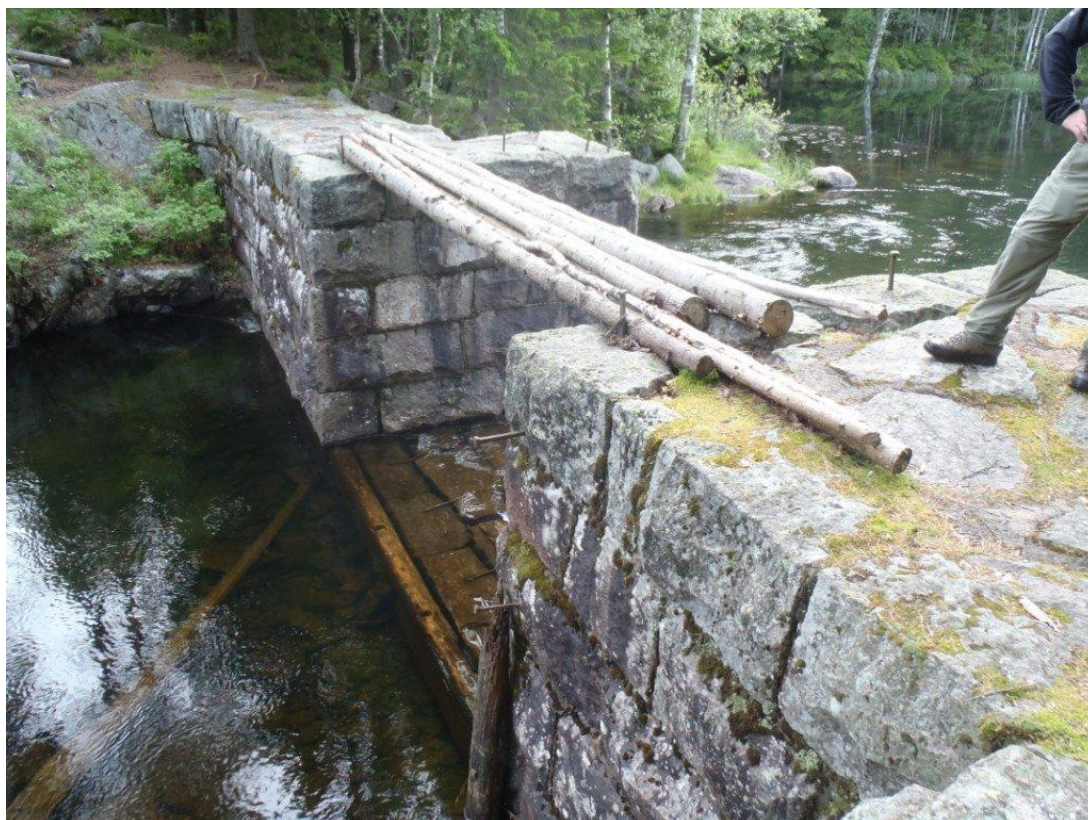
Figur 142. Dammen i utløpet av Gåslungen. Reguleringsanordningene er fjernet og innsjøen er dermed senket til LRV. Dammen er i dag ikke noen vandringsperre for fisk. Foto: VAV.
