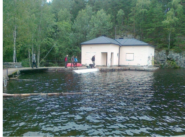
Dammen sett ovenfra med damhus hvorfra tappingen styres
