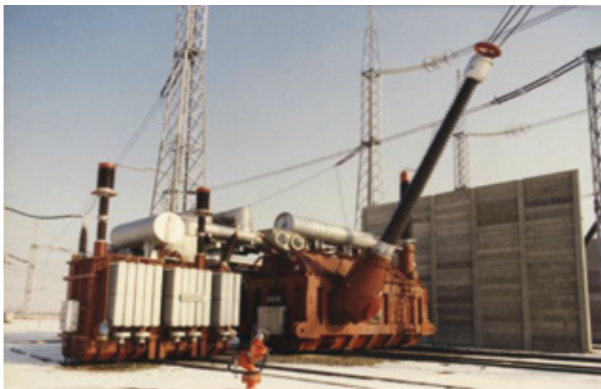
A GANZ VILLAMOSSÁGI MŰVEKBEN GYÁRTOTT 1100 MVA-ES, 750/400 KV-OS TRANSZFORMÁTOR EGYIK FÁZISA
