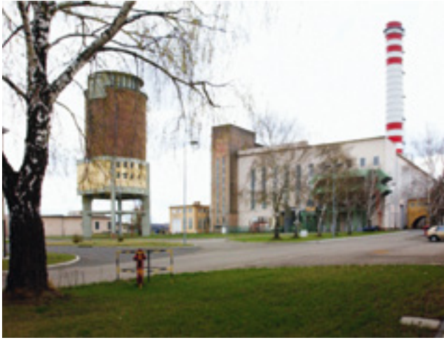
3. KÉP: A LŐRINCI GÁZTURBINÁS ERŐMŰ
