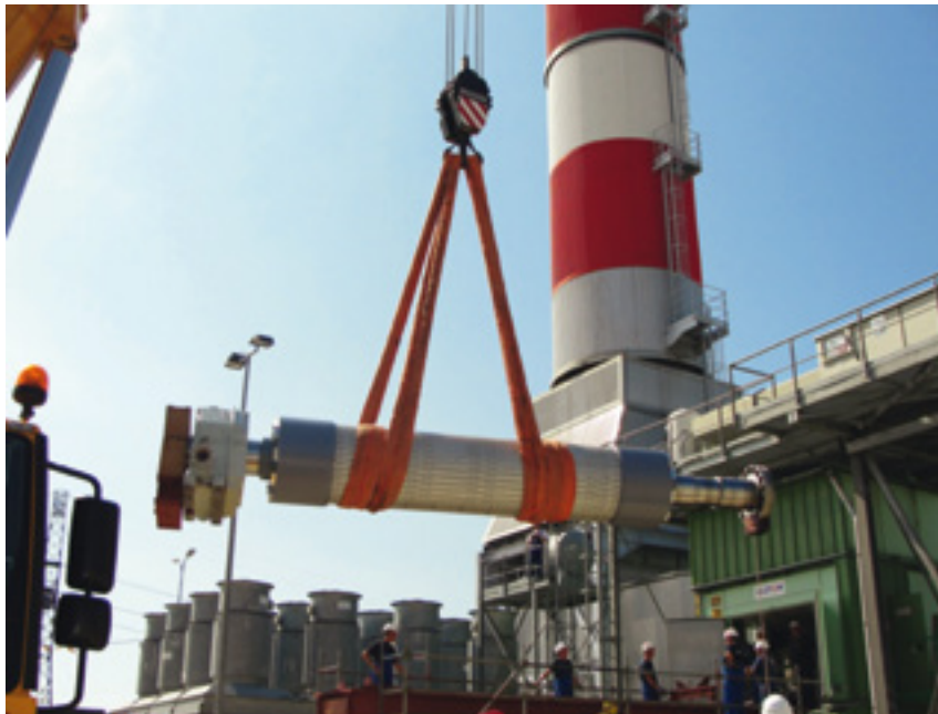
5. KÉP: A LITÉRI GÁZTURBINÁS ERŐMŰ KARBANTARTÁSA - GENERÁTORKIFÜZÉS
