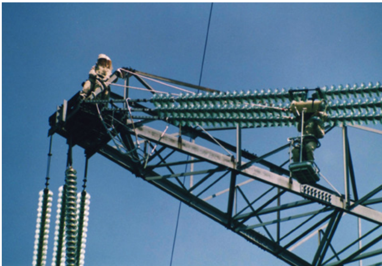
750 KV-OS FESZÍTŐLÁNC TÖRÖTT ÜVEGSZIGETELŐJÉNEK CSERÉJE FESZÜLTÉG ALATT DR. CSIKÓS BÉLA FAM TECHNIKÁJÁVAL
