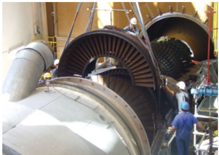
7. KÉP: A LŐRINCI GÁZTURBINÁS ERŐMŰ KARBANTARTÁSA – TURBINA HÁZFELBONTÁS
