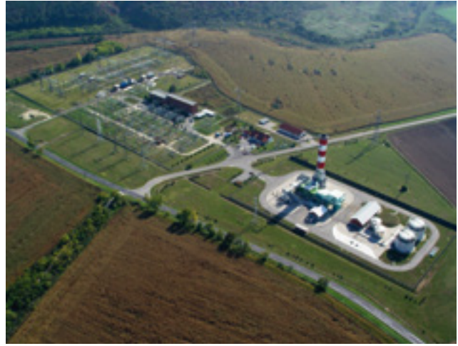
2. KÉP: A LITÉRI GÁZTURBINÁS ERŐMŰ ÉS ALÁLLOMÁS
