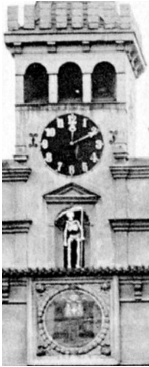
A different story: The Townhall of Německý Brod (Havlíčkův Brod) after 1902.
