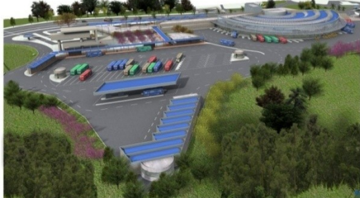
El mayor perímetro del semicírculo ofrece más capacidad de plataforma favoreciendo la operación de los buses y taxis.
