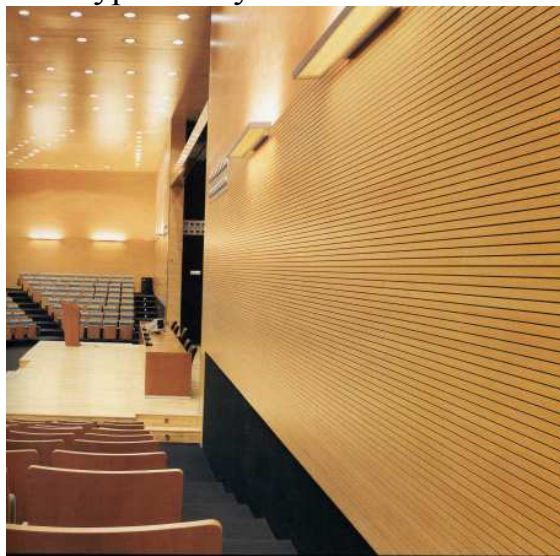
Рис. 12. Общий вид нового резонансного звукопоглотителя
