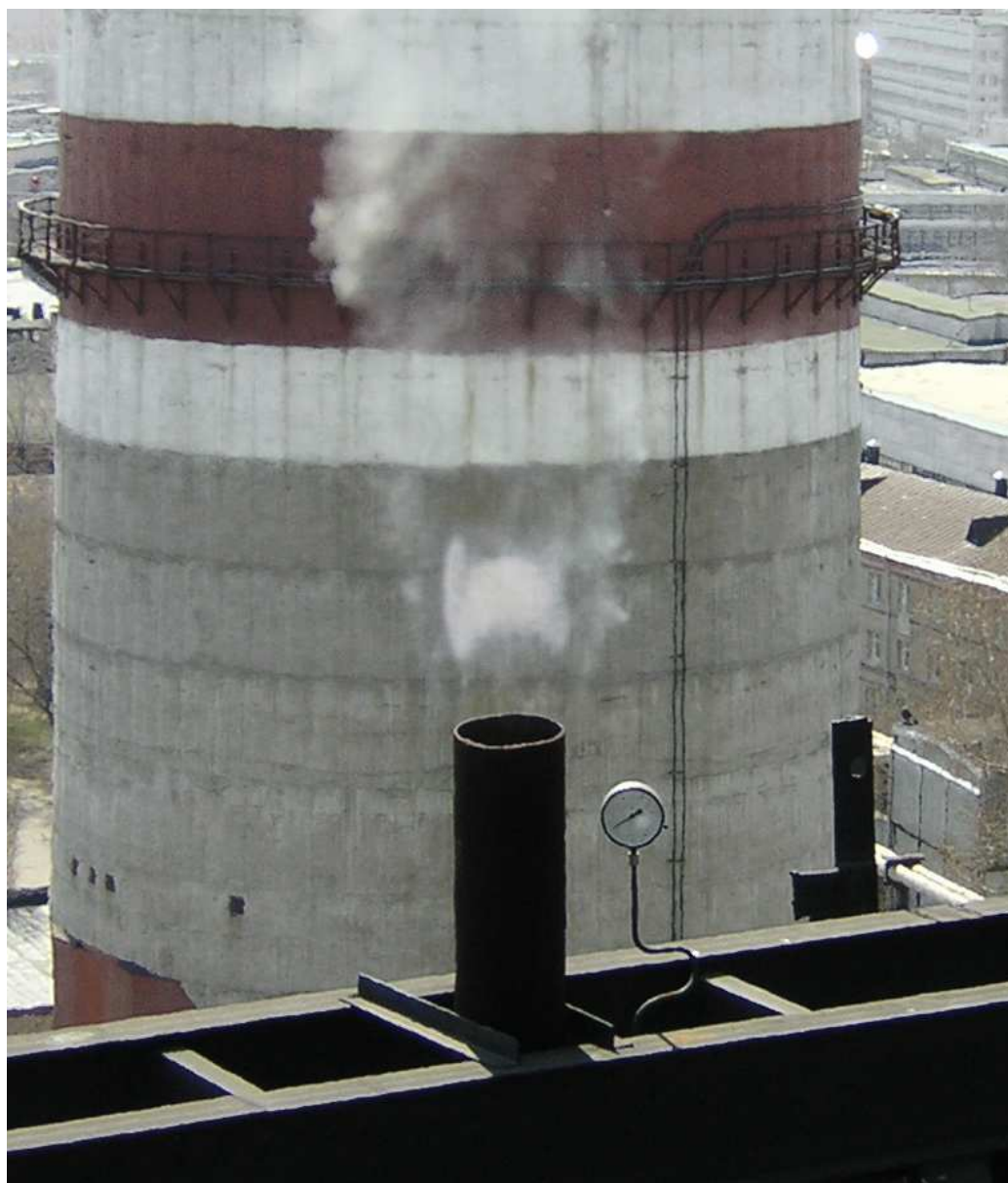
Рис.1. Недорасширенная струя пара, образующаяся при выбросе пара в результате срабатывании ГПК котла большой паропроизводительности
