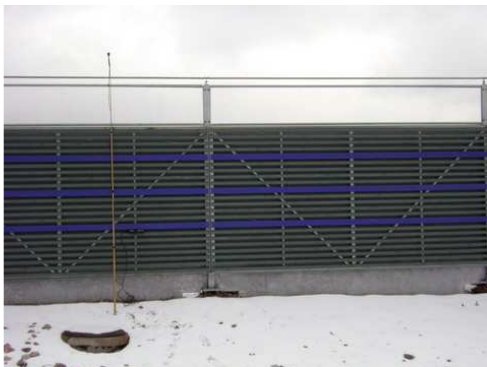
Рис. 5. Вид на опорную точку
