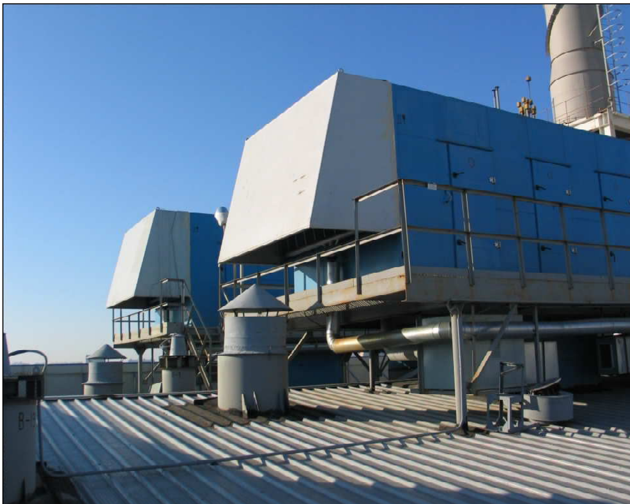
Рис. 1. На крыше машинного зала ГТЭС-12. КВОУ с антиобледенительными устройствами закрыты звукоизолирующими экранами-козырьками
