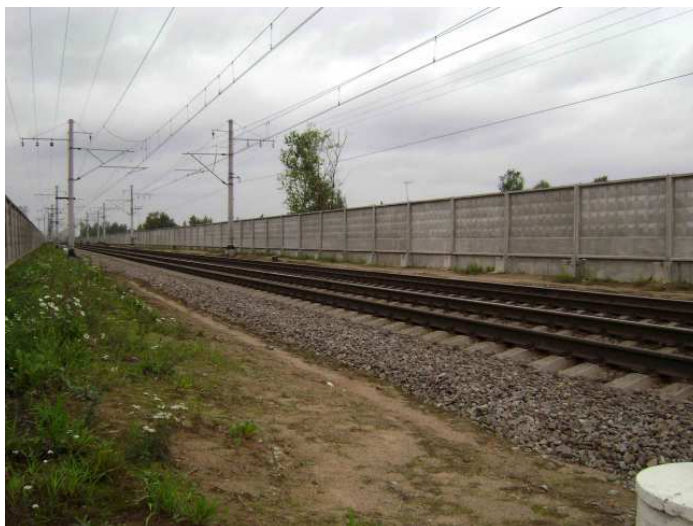
Рис. 6. Вид на бетонный АЭ
