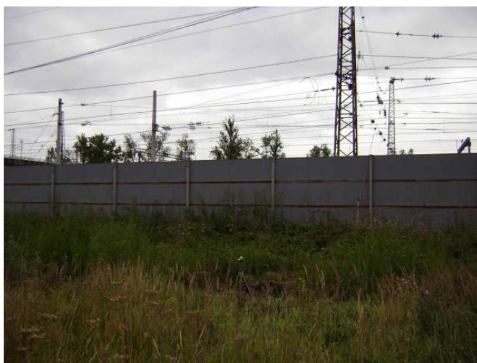
Рис. 7. Вид на металлический АЭ на станции Чудово
