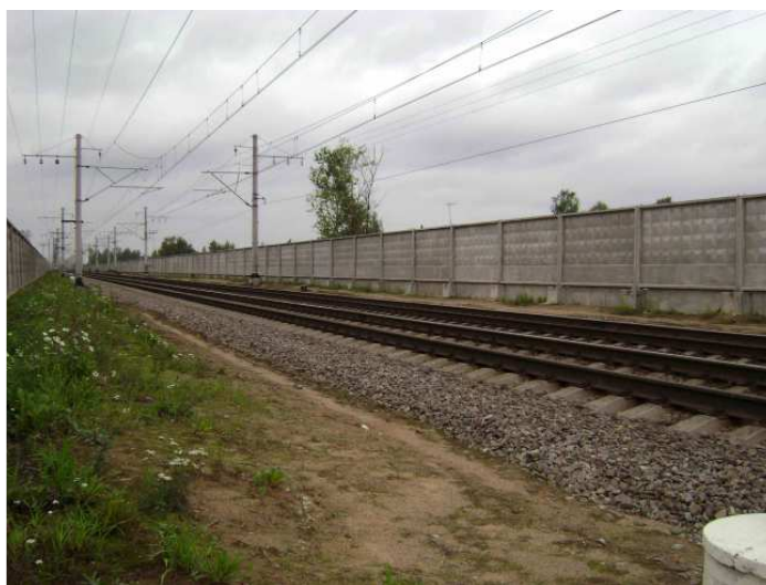
Рис. 16. Общий вид бетонного экрана
