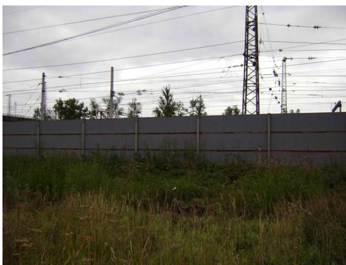
Рис. 17. Общий вид металлического экрана
