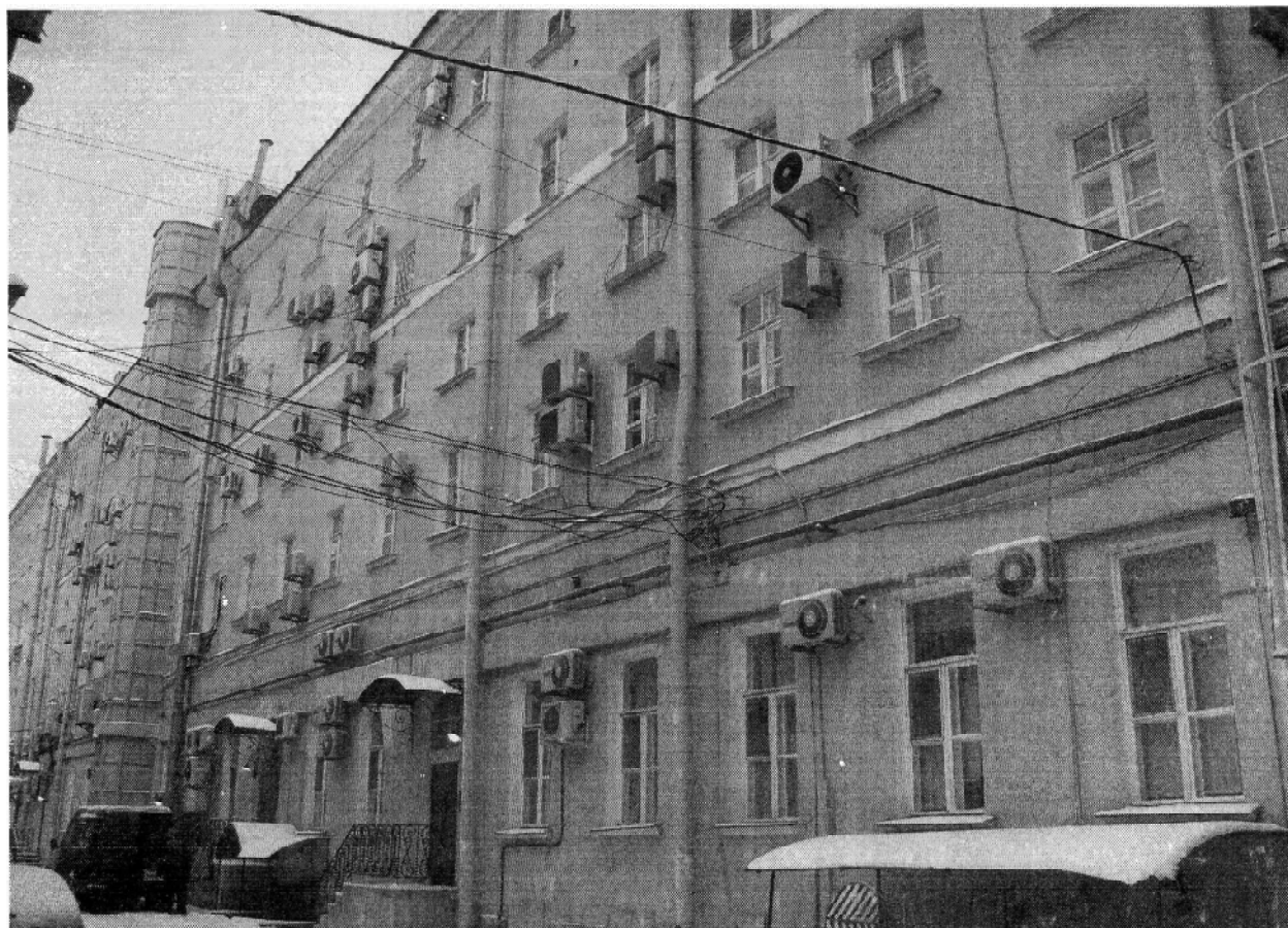
Рис.1. Наружные блоки Сплит-систем кондиционирования воздуха на фасаде дома по Итальянской ул. д. 5.
