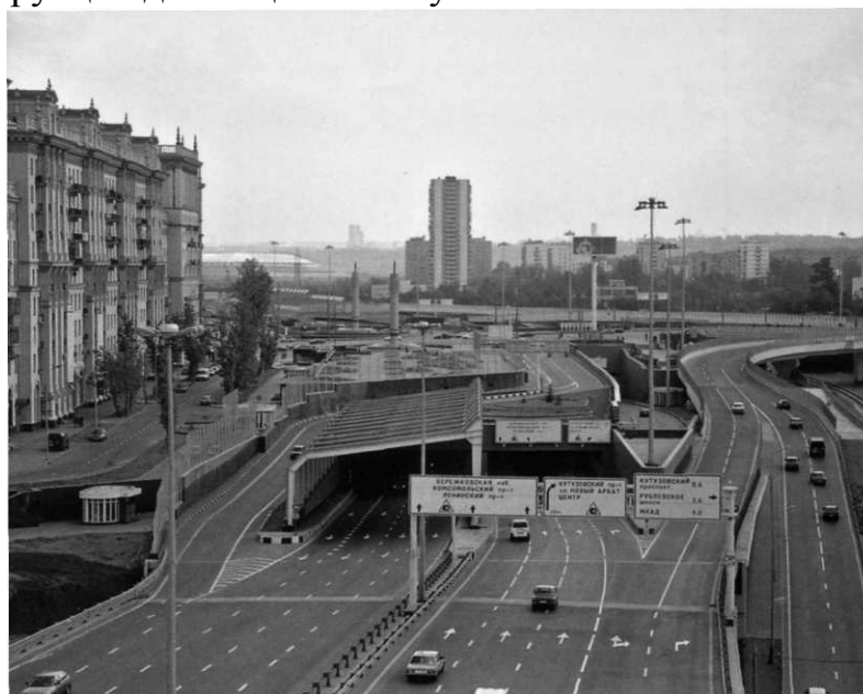
Рис. 3. Придорожные экраны, расположенные на выездах из тоннеля на пересечении 3-го кольца и Кутузовского проспекта.
