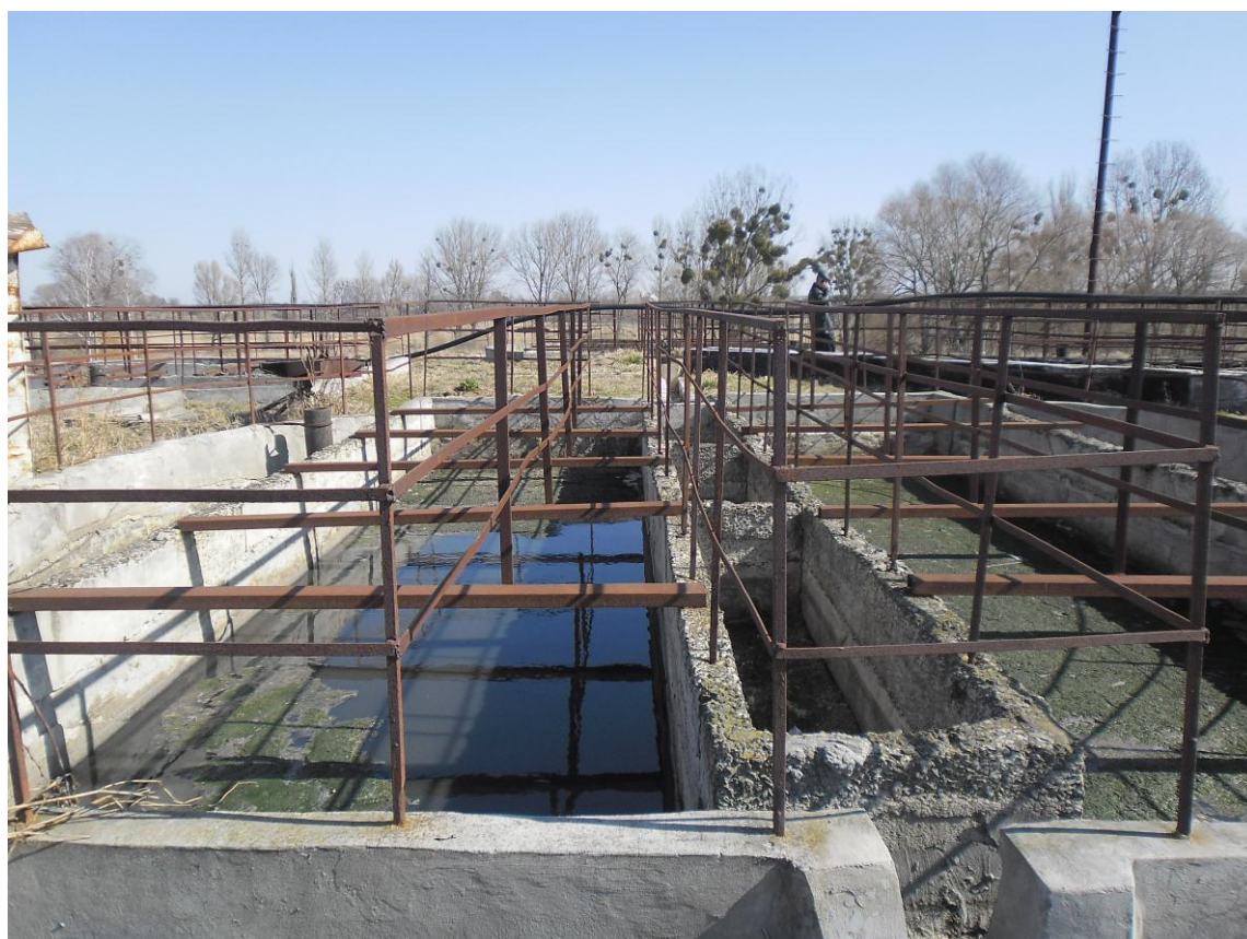
Очисні споруди ДП «Водоканал Ходорів»
