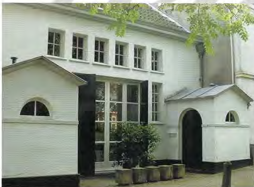
De oudste school van Bloemendaal. Het uitbouwje links was het klompenhok van de leerlingen en het uitbouwje rechts was het 'secret' (toilet).
