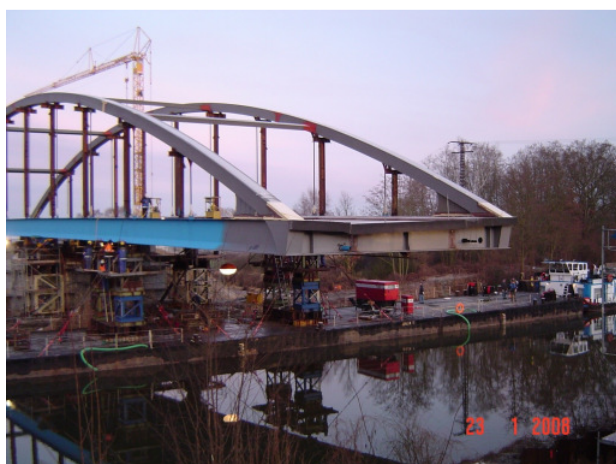
Brückeneinschub über Ponton
