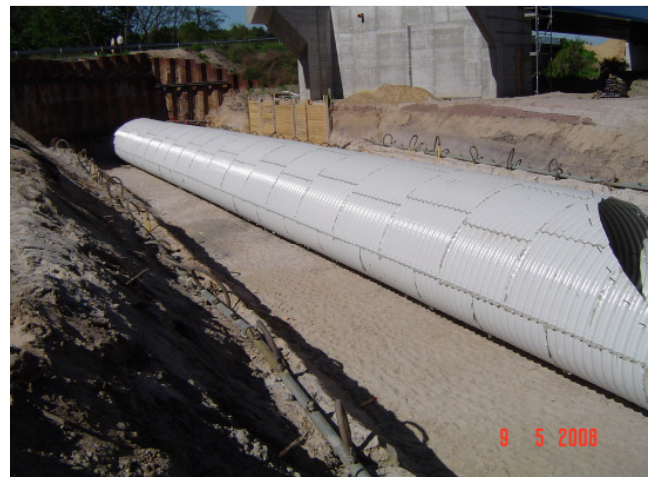
Montage Wellstahldurchlass
