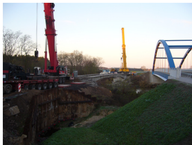
Abbruch altes Bauwerk
