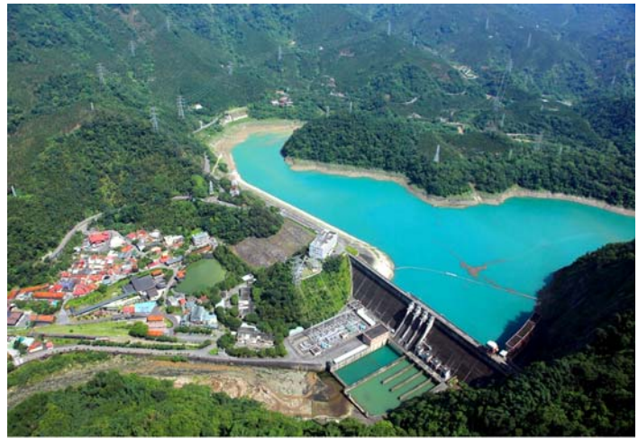
▶ 照片 10 明潭抽蓄發電廠下池
