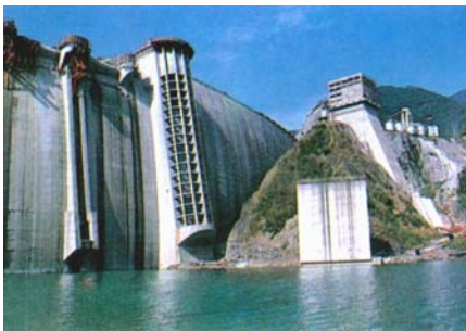
照片 3 施工中的翡翠水庫電廠進水口 (直立格框)
