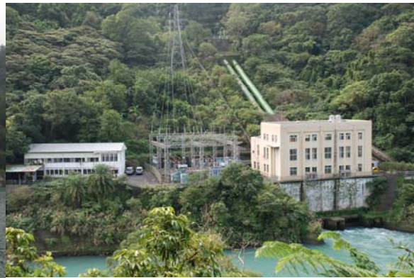
照片 2 桂山發電廠壓力鋼管、廠房、開關場及發電尾水*
