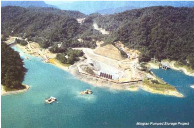
◀ 照片 9 明潭抽蓄發電廠上池 (日月潭)及取水口(施工中)
