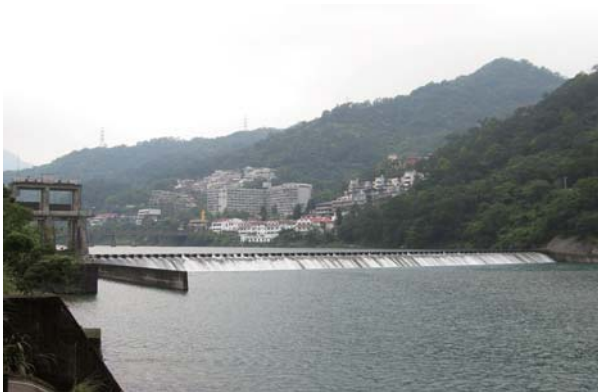
照片 1 粗坑電廠取水堰*
