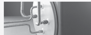
Bild 3.4.9 Einbaubeispiel für eine Geräteverrohrung mit semiflexiblen Ringwellschläuchen
