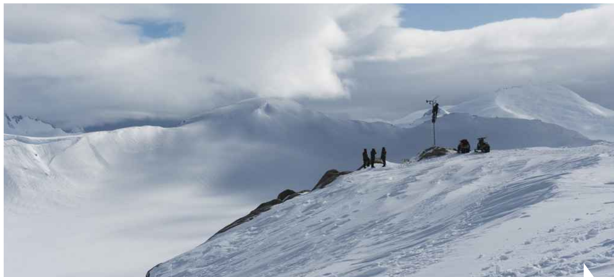
INSTALACIÓN DE LA ESTACIÓN METEOROLÓGICA FIJA EN LA MESETA DEL GLACIAR SAN RAFAEL. AGOSTO, 2013.
