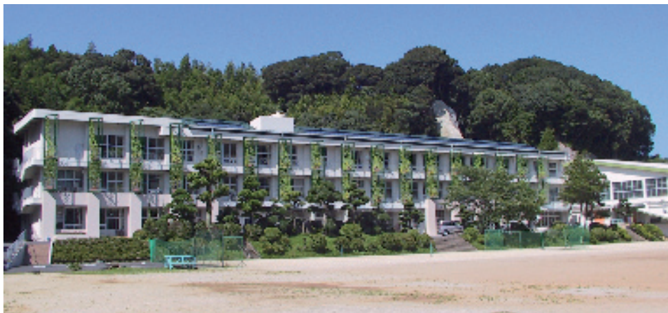
改修された管理・普通教室棟南側外観。1階外壁にみえる耐震補強のフレーム（エコフレーム）で耐力度を確保して、2、3階は、植物による緑のカーテンで西日を防ぐ。校地の随所に樹木や緑が植えられた緑の学校は、湿度がこもりやすい環境にもあり、改修は、光・熱・風がポイントとなった※
