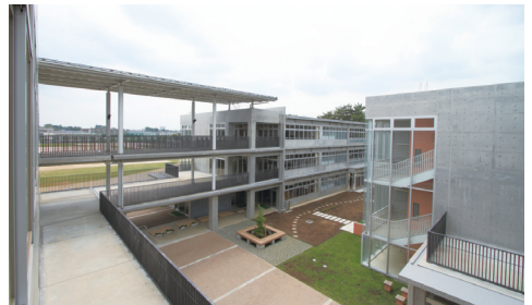
管理・特別教室棟から普通教室棟をみる。ブリッジとふれあいテラスを介してつながっている様子がよくわかる
