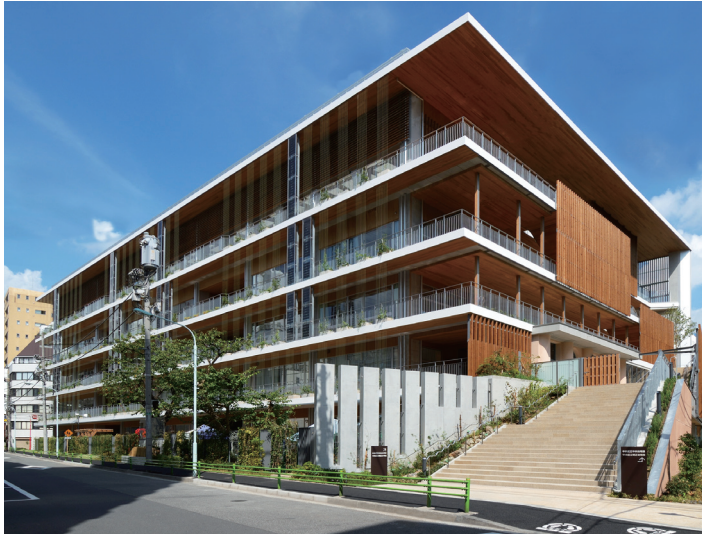
南東側外観。1階に水泳プール、3階に体育館、屋上に校庭を確保し、敷地いっぱいを使って施設を整備した
