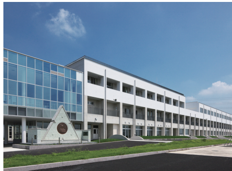
グラウンド側からみる管理・特別教室棟
