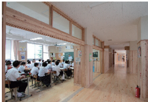
改修された普通教室棟廊下。木材だけでなく壁のイグサクロスの調湿機能もあって、これまで悩みの種だった結露が、改修後は全くなくなったという
