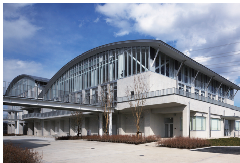
第一体育館外観(南西側)
