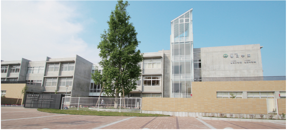
東側の正面アプローチからみえるのは管理・特別教室棟。コンクリートを基調にした外観は、アクセントのようにガラス仕上の階段室が換気塔を兼ねてつくられて、校舎にシンボル性を持たせている※
