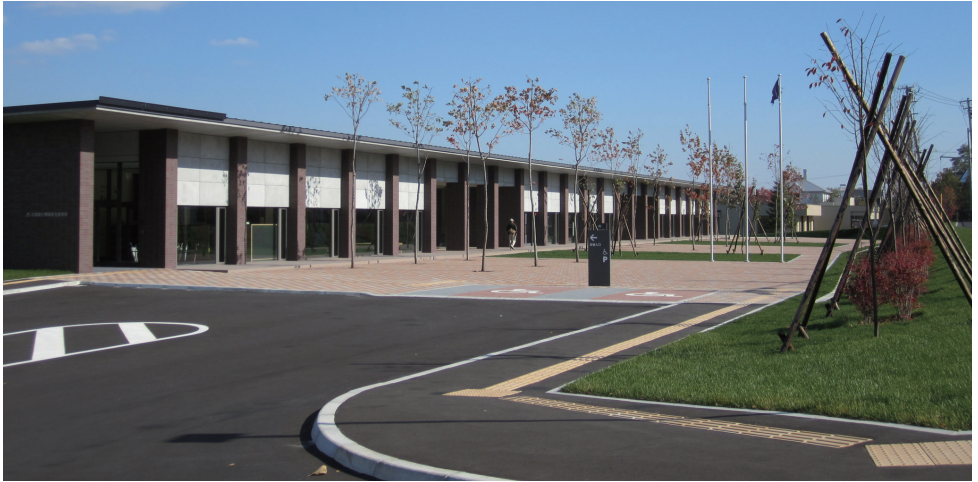
校舎棟前庭（南西側）。3棟の校舎を渡り廊下でつなぎ一体感を形成
