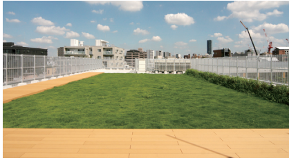
緑の絨毯のような屋上緑化の芝生。自動灌水システムを採用して、断熱・保温効果も期待※
