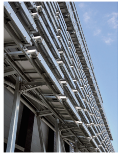
ソーラーエンヴェロップと建物を離して、ソーラーコリドーからの通風を確保 ソーラーエンヴェロップと南側太陽光パネルを見上げる
