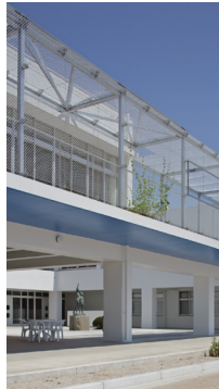
防球ネットで安全性を確保しているスカイコリドー
