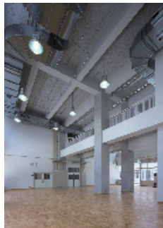
建築デザイン系実習棟の軸組・建築施工実習室。2階吹抜けとして、2階建の住宅をつくることのできる空間を確保した
