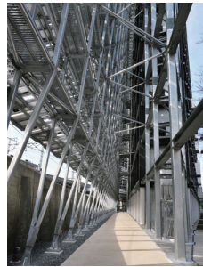
ソーラーエンヴェロップと建物を離して、ソーラーコリドーからの通風を確保 ソーラーエンヴェロップと南側太陽光パネルを見上げる
