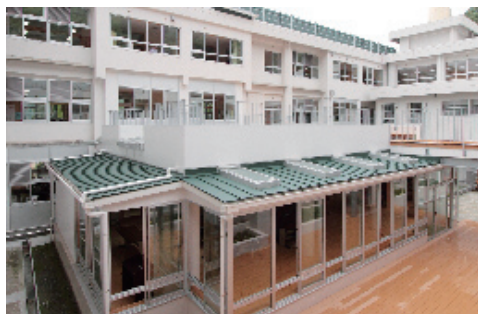
普通教室棟と特別教室棟の間に増築されたエコライブラリー。渡り廊下の下になる右端には、地域コミュニティが活動するために直接出入りできる入口もつくりされている。また、奥の普通教室棟北側の壁面には、新しく取付られたナイトパーズ用のガラリを確認できる
