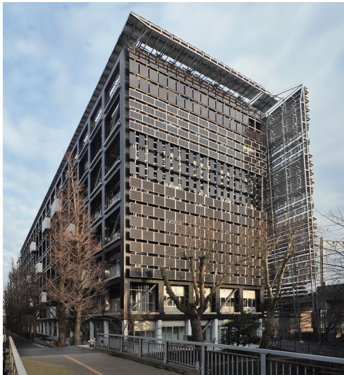
西側より建物を望む。壁面に太陽光パネル
