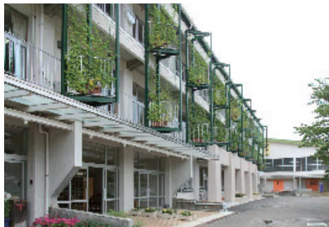
庇をガラスに交換して明るくなったといわれている昇降口。緑のカーテンは、今年度はユウガオとゴーヤを植えている。その比較も学びのテーマにできる
