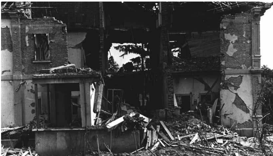
Patrimonio edilizio sinistrato nel bombardamento del 6 luglio 1944.
