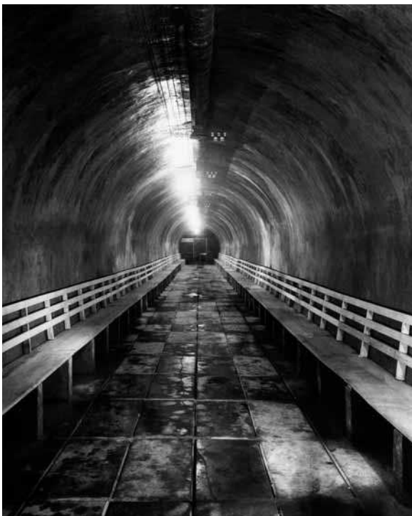
La galleria ricovero del "Garbagni" al termine della sua costruzione.
