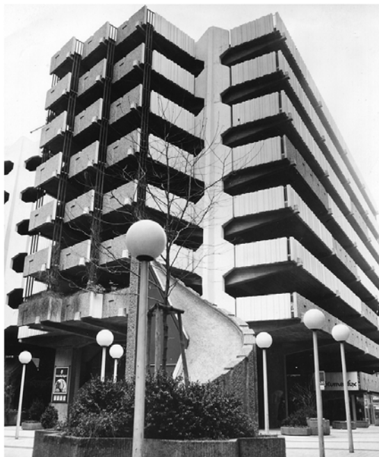
Abb. 21: Parkhaus Katharinenklosterhof. Architekt Carsten Schröck
