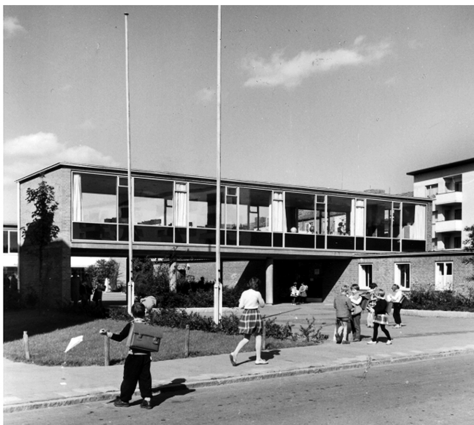
Abb. 11: Schule an der Gottfried-Menken-Straße - Schulbibliothek. Architekten Richter und Kläner
