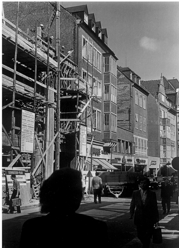
Abb. 7: Aufbau der Sögestraße 1952
