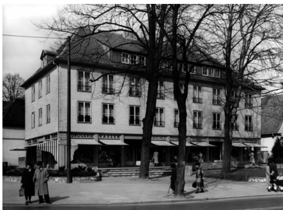
Abb. 62: Geschäftshaus Schwachhauser Heer Straße
