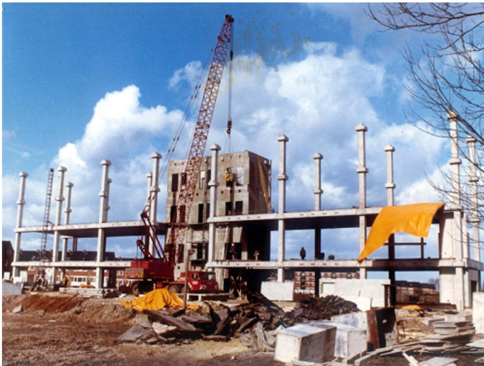
Abb. 22: Baustelle der Gesamtschule Ost
