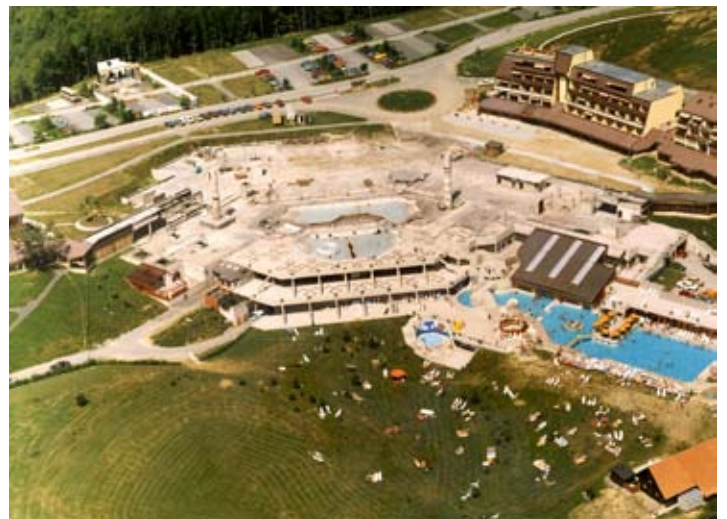
Nach der Entfernung des Brandschutts (Foto Langhans)
