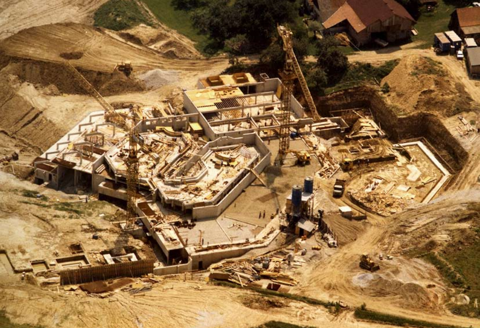
Luftaufnahme der Baustelle vom Juli 1978 (Foto Langhans Fürstenfeld)
