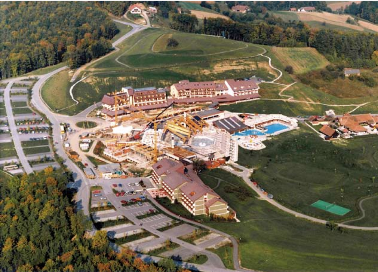
Luftaufnahme vom Wiederaufbau 1985 (Foto Langhans)
