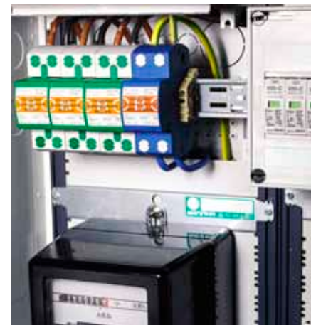
Installation im Verteiler (V Verdrahtung) Quelle: OBO Bettermann
