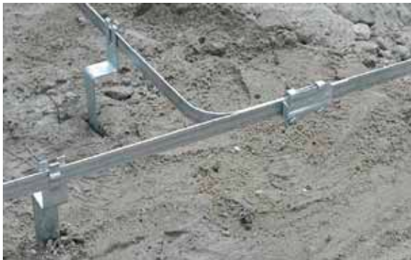
Bild 7: Abstandshalter (Quelle DEHN)
