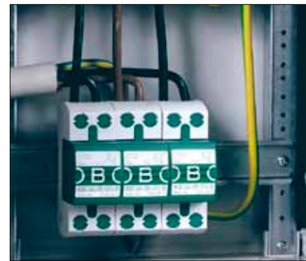
Installation im Verteiler (V Verdrahtung) Quelle: OBO Bettermann
