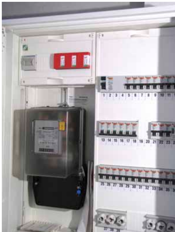
Bild 16: TN-C-S-System Vorzählerbereich, Realbild. Montage der Ableiter im Zählerschrank (links) oder im separaten Gehäuse (rechts). Auf dem Ableiter zum N-Leiter wurde verzichtet, da die PEN-Aufteilung in unmittelbarer Nähe erfolgt (3 + 0 Schaltung).
