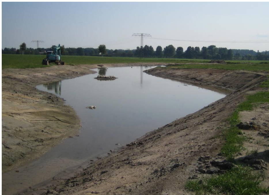
Im Bau befindliche Wasserrückhaltefläche (Foto: Teilnehmergemeinschaft S 177 OU Radeberg/Großerkmannsdorf)
