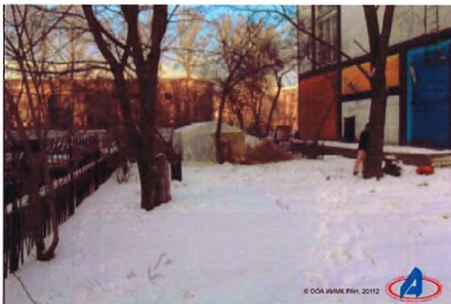
СПб., 2012 г. Наб. р. Мойки, 102. Каркасная палатка над шурфом №1. Вид с Ю.
