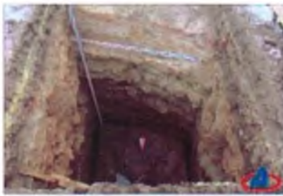
СПб., 2012 г. Наб. р. Мойки, 102. Шурф №1. Материк и северная стенка фундамента башни. Вид с С.
