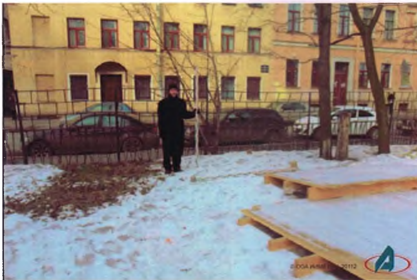
СПб., 2012. Наб. р. Мойки, 102. Место закладки шурфа 5. Вид с ЮВ
