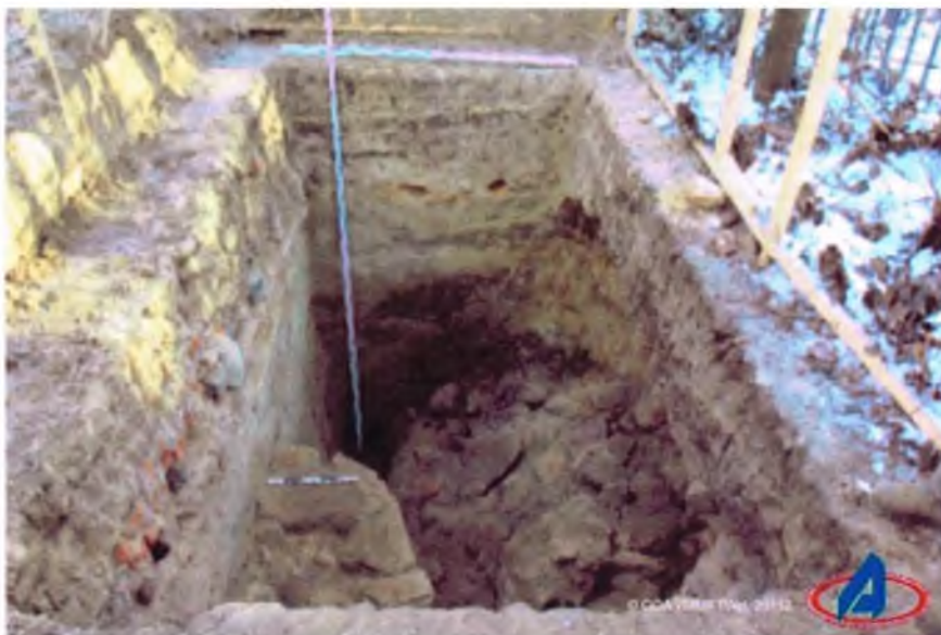
СПб., 2012 г. Наб. р. Мойки, 102. Шурф №2. Восточная стенка. Вид с З.
