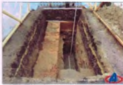
СПб., 2012. Наб. р. Мойки, 102. Шурф 4. Западная стенка и фундамент внешней стены. Вид с В
