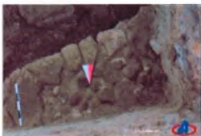
СПб., 2012 г. Наб. р. Мойки, 102. Шурф №2. Каменный фундамент. Вид с С.
