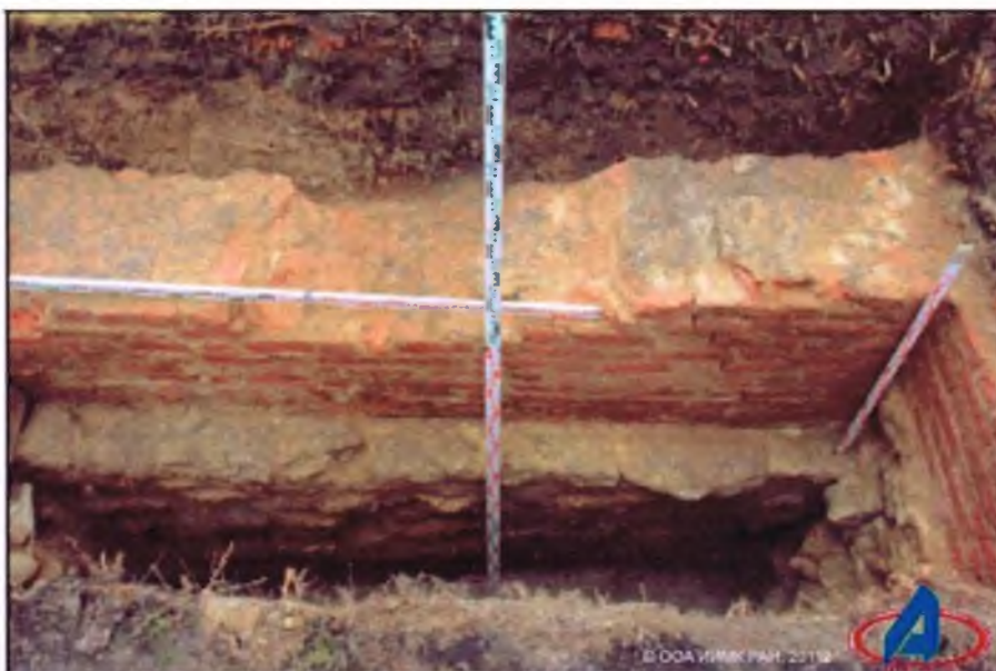
СПб., 2012. Наб. р. Мойки, 102. Шурф 4. Стены фундамента (1 и 2). Вид с С
